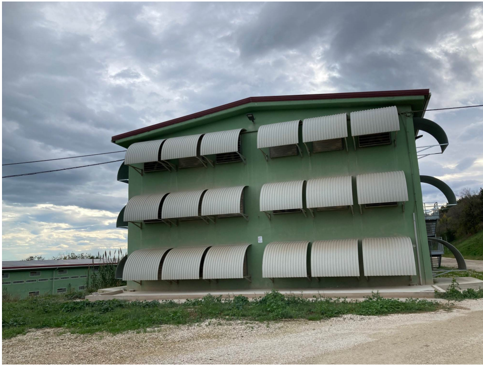
Foto 1 e 2: lato Nord e Ovest capannone 1.1 con nuovi deflettori.
