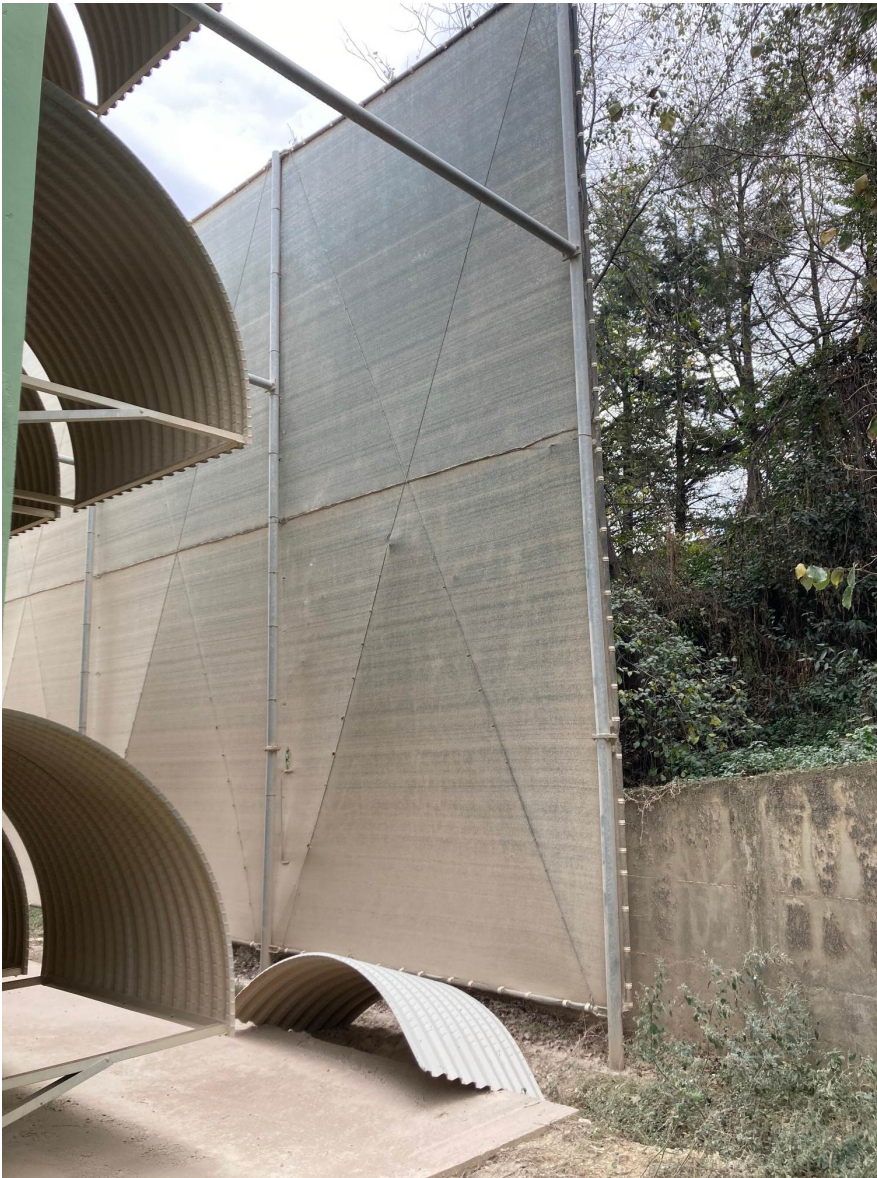
Foto 3: lato Sud capannone 1.1 con nuovi deflettori e barriera già esistente.
