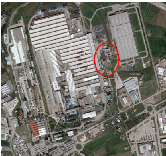
FOTO 1 – ubicazione impianto Cogenio S.r.l. – Stabilimento di San Salvo (CH)
