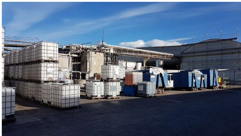
Foto 8: deposito reagenti e rifiuti
