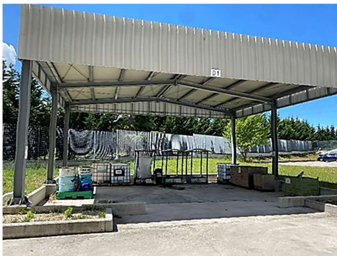
FOTO 5: AREA DEPOSITO RIFIUTI D1
