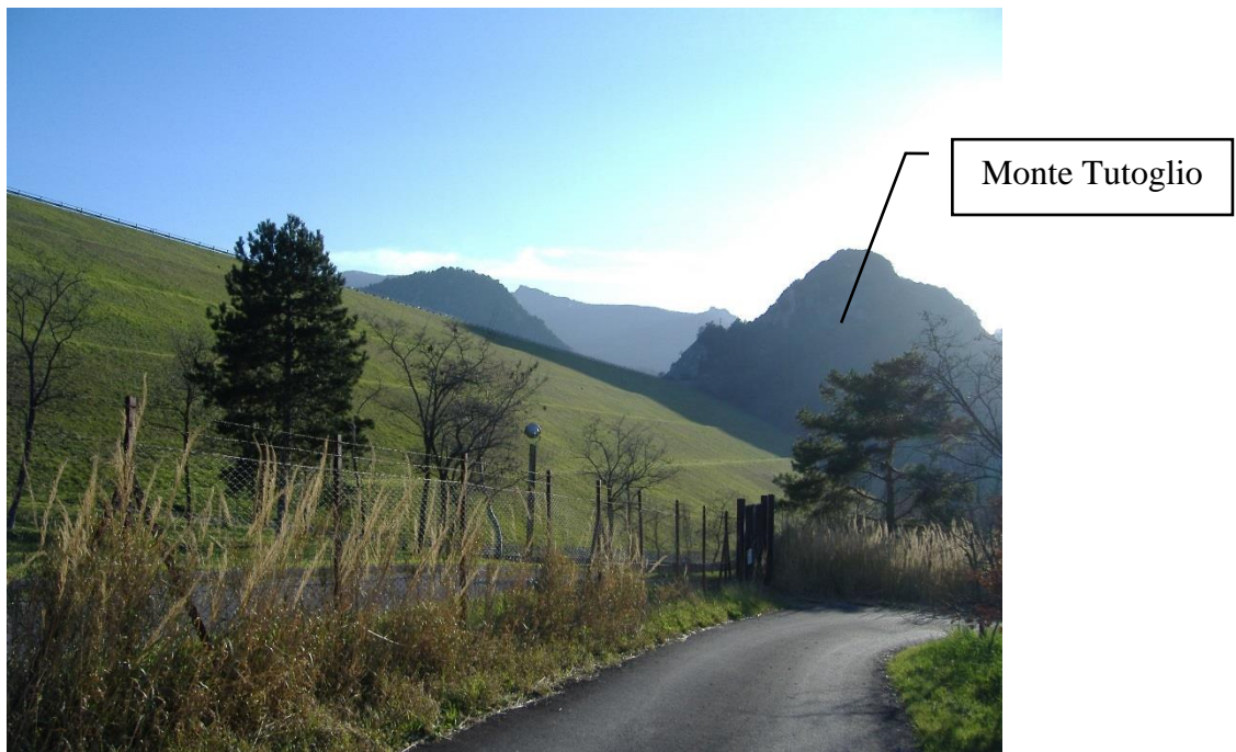
Fig. 20: Diga di Bomba vista dalla strada al piede; sulla destra M.Tutoglio.
