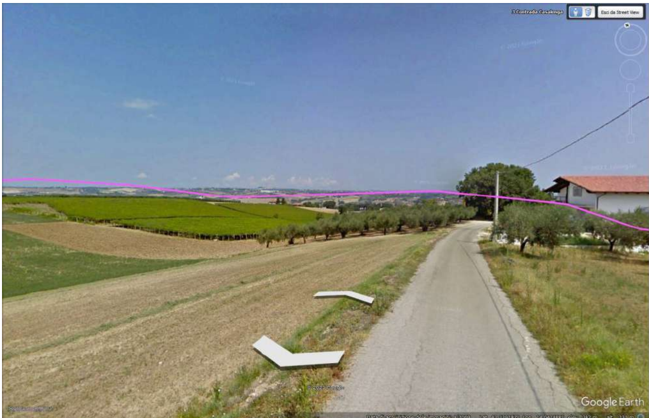
LA FOTO, SCATTATA DA CONTRADA CASALONGA, MOSTRA IL PERCORSO DELL'ELETTRODOTTO PROVENIENTE DA CONTRADA FEUDO (A SINISTRA) E PROSEGUENTE VERSO CONTRADA SAN MARTINO E CONTRADA MILANO (A DESTRA).
