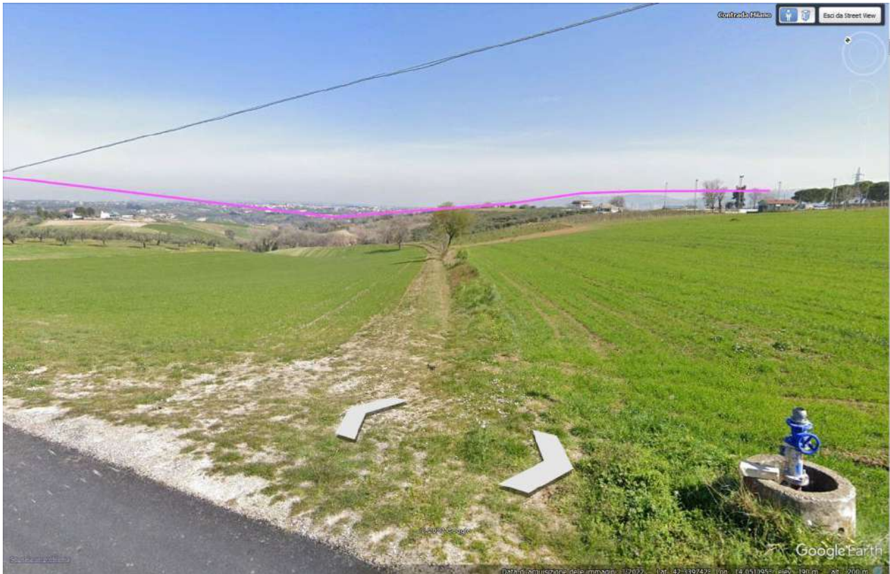
LA FOTO MOSTRA LA STRADA INTERPODERALE (S13) ATTRAVERSATA DALL'ELETTRODOTTO, PROVENIENTE DA SINISTRA.
