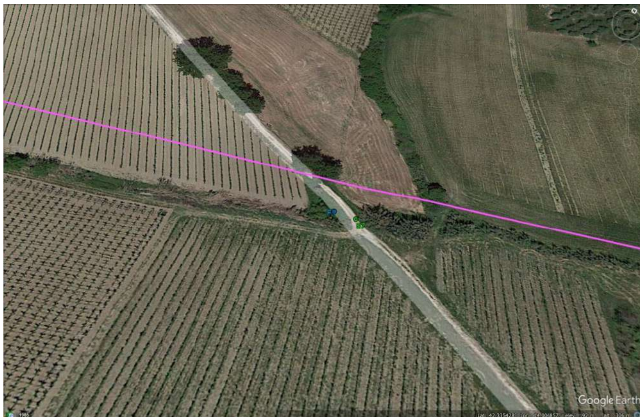
FOTO AEREA DELLE PRECEDENTI INTERSEZIONI.
