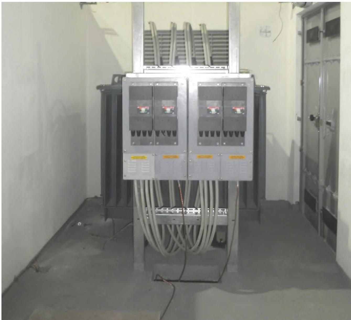
Box in calcestruzzo armato prefabbricato per apparecchiature elettriche per altitudini fino a 1000 metri sul livello del mare.
