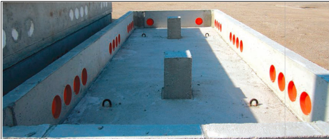
Figura 16 Vasca di fondazione in CAV
