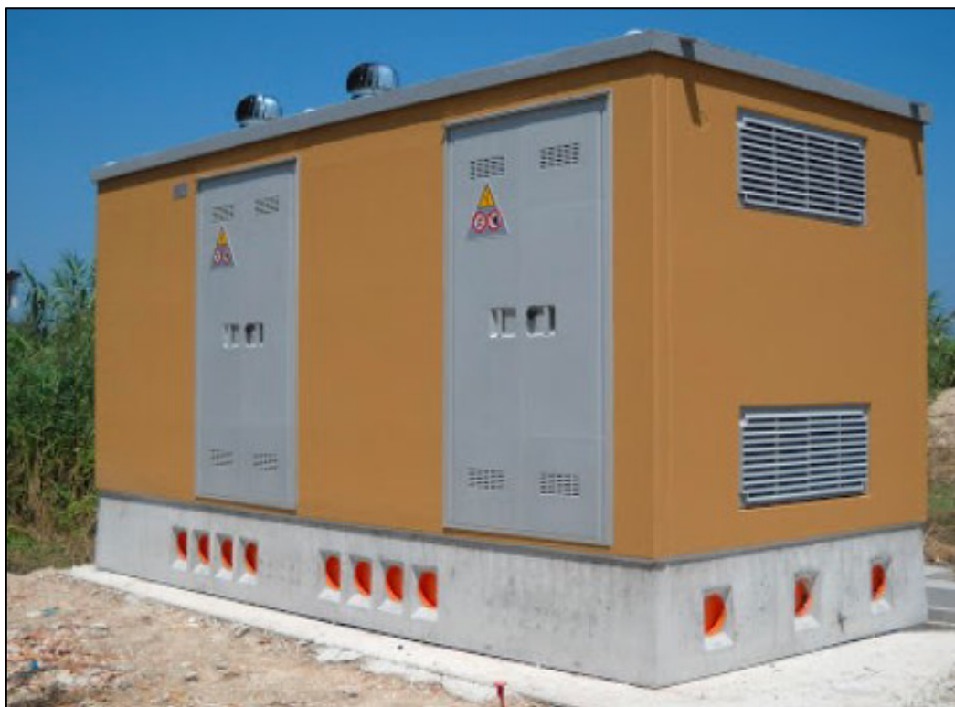
Figura 17 esempio cabina in CAV
