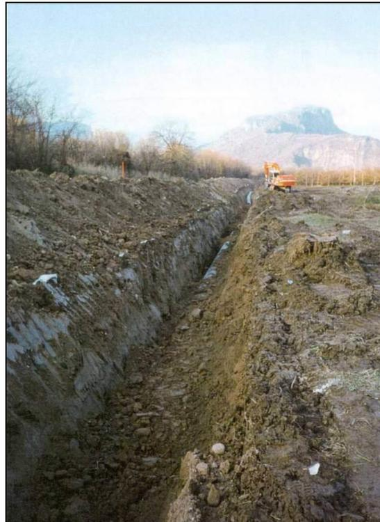
**Fig. 7.5 - Operazione di rinterro della condotta**
