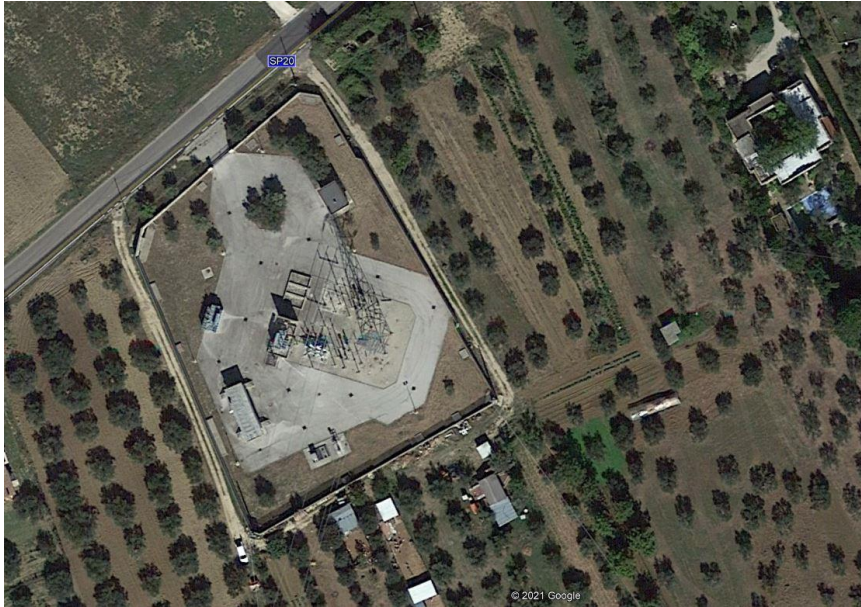
Figura 3 - Immagine area cabina primaria AT/MT ROSCIANO
