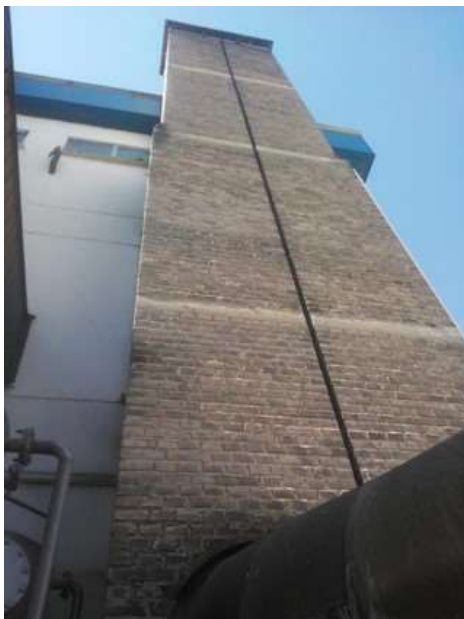
Foto 5: caldaia produzione vapore emissione 2P
