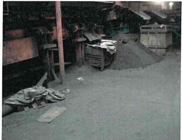
Particolare interno Reparto raffreddatore Shenck con grande quantità di polvere depositata
