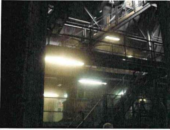
Reparto preparazione e miscelazione terre molto polveroso
