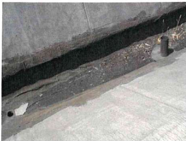
Particolari delle canalette di raccolta acque meteoriche del tetto contenenti una copiosa quantità di polvere nera
