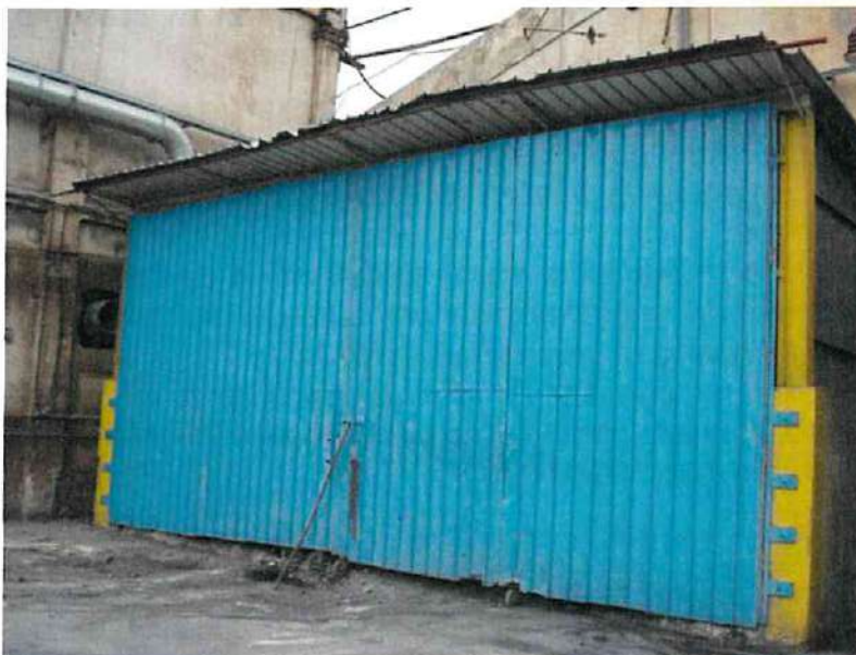
Deposito scorie chiuso con porta metallica
