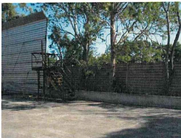
Lato sud-est recinzione confinante con unità abitative
