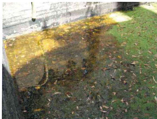
Interno vasca di accumulo acque meteoriche con presenza di sostanza oleosa giallastra
