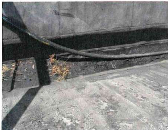
Particolari delle canalette di raccolta acque meteoriche del tetto contenenti una copiosa quantità di polvere nera
