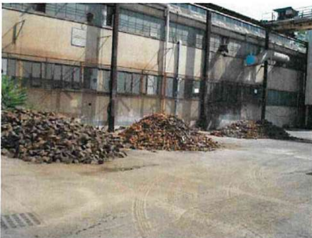
Piazzale esterno all'area di carico dei forni
