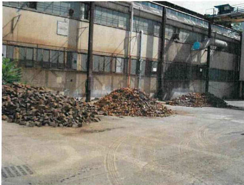
Deposito delle materie prime all'esterno dell'area forni
