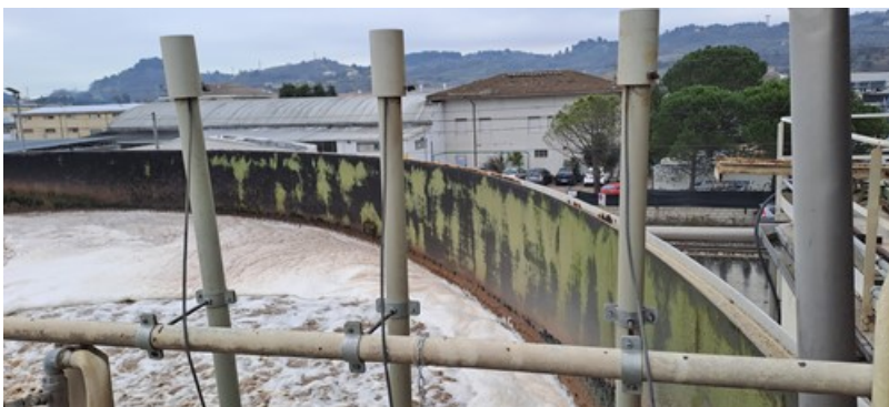
FOTO 7 – SONDE PER SOLIDI SOSPESI, OSSIGENO DISCIOLTO E POTENZIALE REDOX
