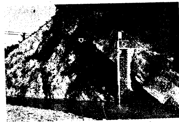
Aventino a Casoli — Stazione idrometrografica e per misure di portata.
