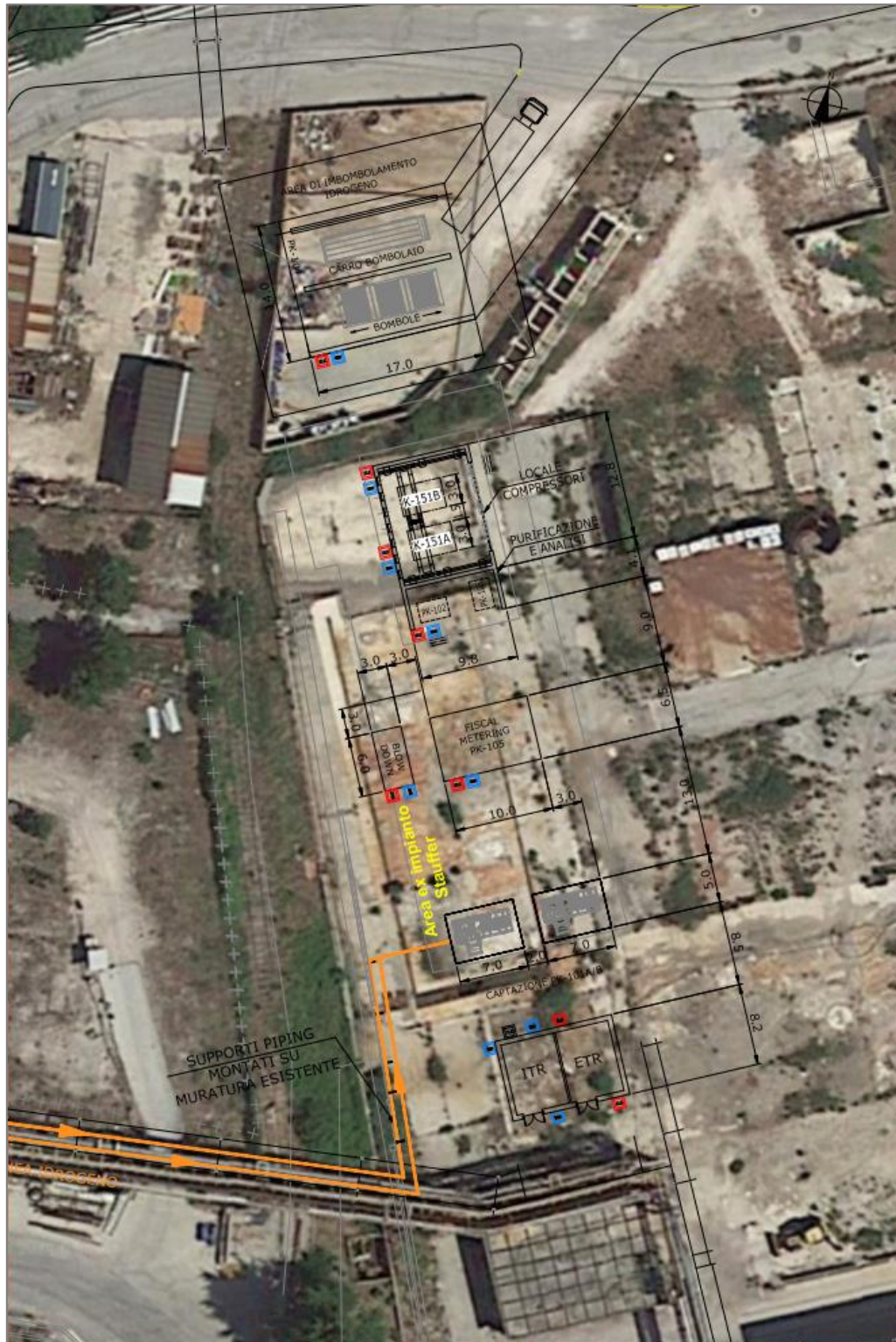
Figura 2-1: Ubicazione dell'impianto "package" Hydrorec
