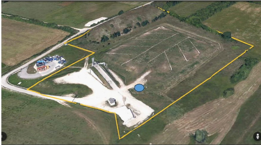
Vista del sito con evidenziata l'area di accumulo del percolato
