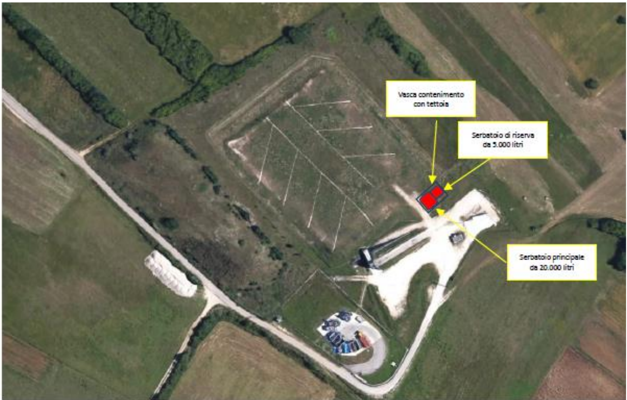
Posizionamento della tubazione e dei serbatoi per la raccolta del percolato
