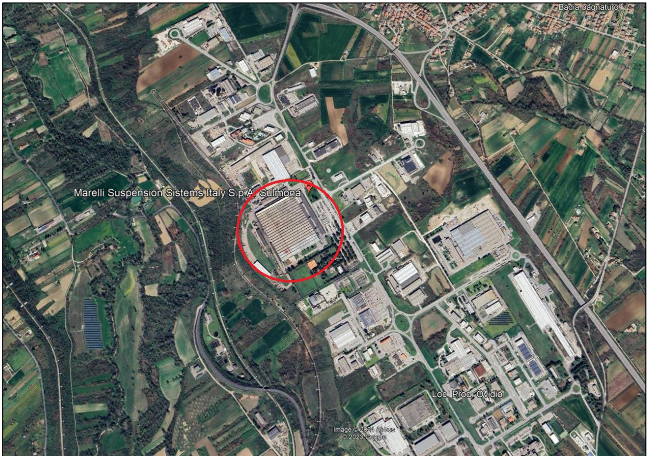
Figura 2 – Localizzazione territoriale di area vasta del sito aziendale, mediante immagine satellitare (Google Earth)
