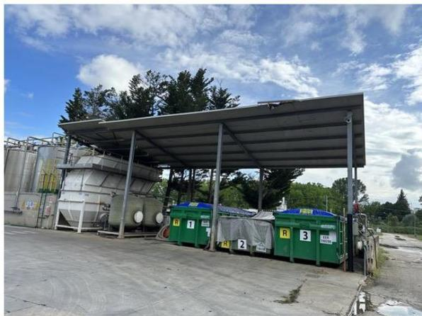
Figura 5 - Particolare stoccaggio fanghi disidratati in container
