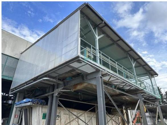
Figura 9 - Particolare copertura filtropresse disidratazione fanghi
