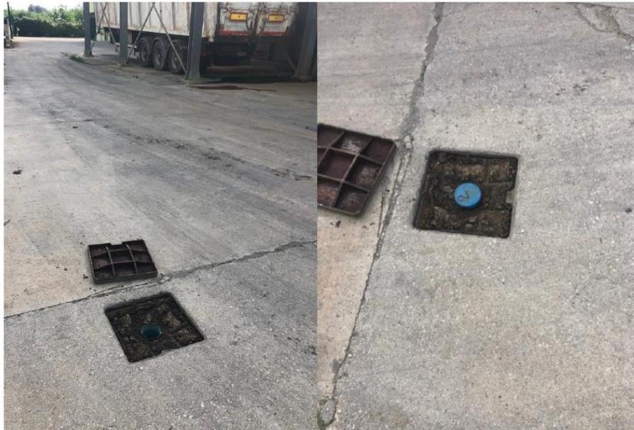
Figura 13 - Particolare piezometro P2
