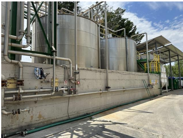
Figura 11 - Particolare bacini di contenimento
