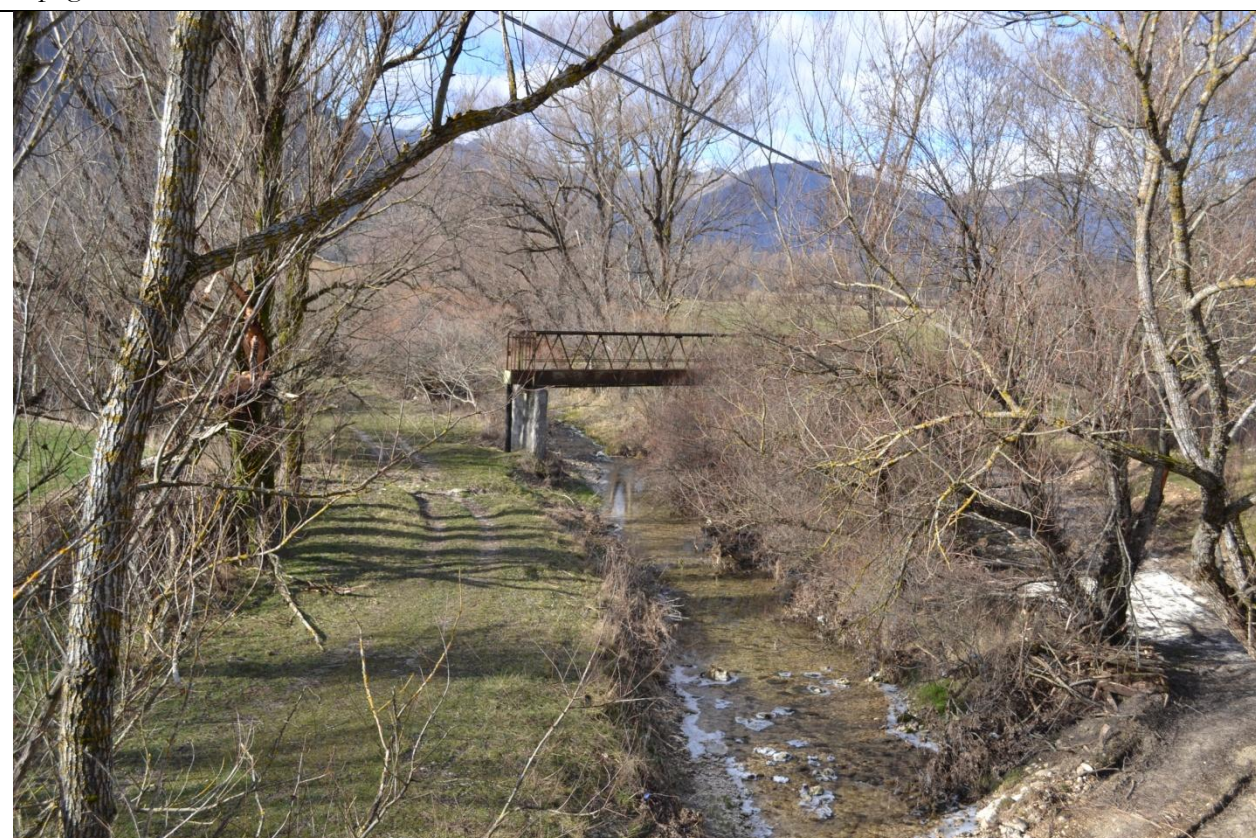
foto 7 tratto di attraversamento del fiume Sangro con TOC in cui verrà rimosso il ponte tralicciato
