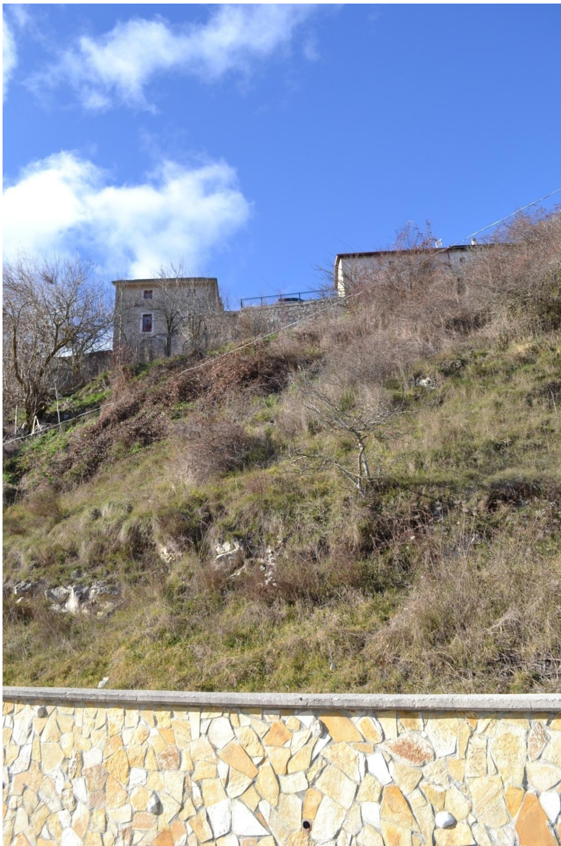
foto 13 (TRATTO 3 TER) tratto in cui la condotta fognaria verrà realizzata lungo il costone da Opi verso la strada comunale
