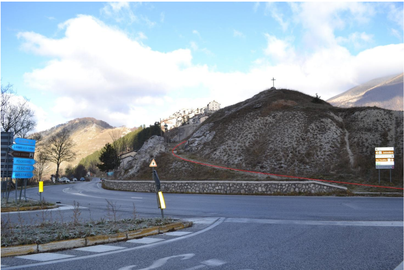
foto 9 (TRATTO 3 BIS) scavo a sezione obbligata dalla strada provinciale lungo la salita verso Opi (strada pedonale)
