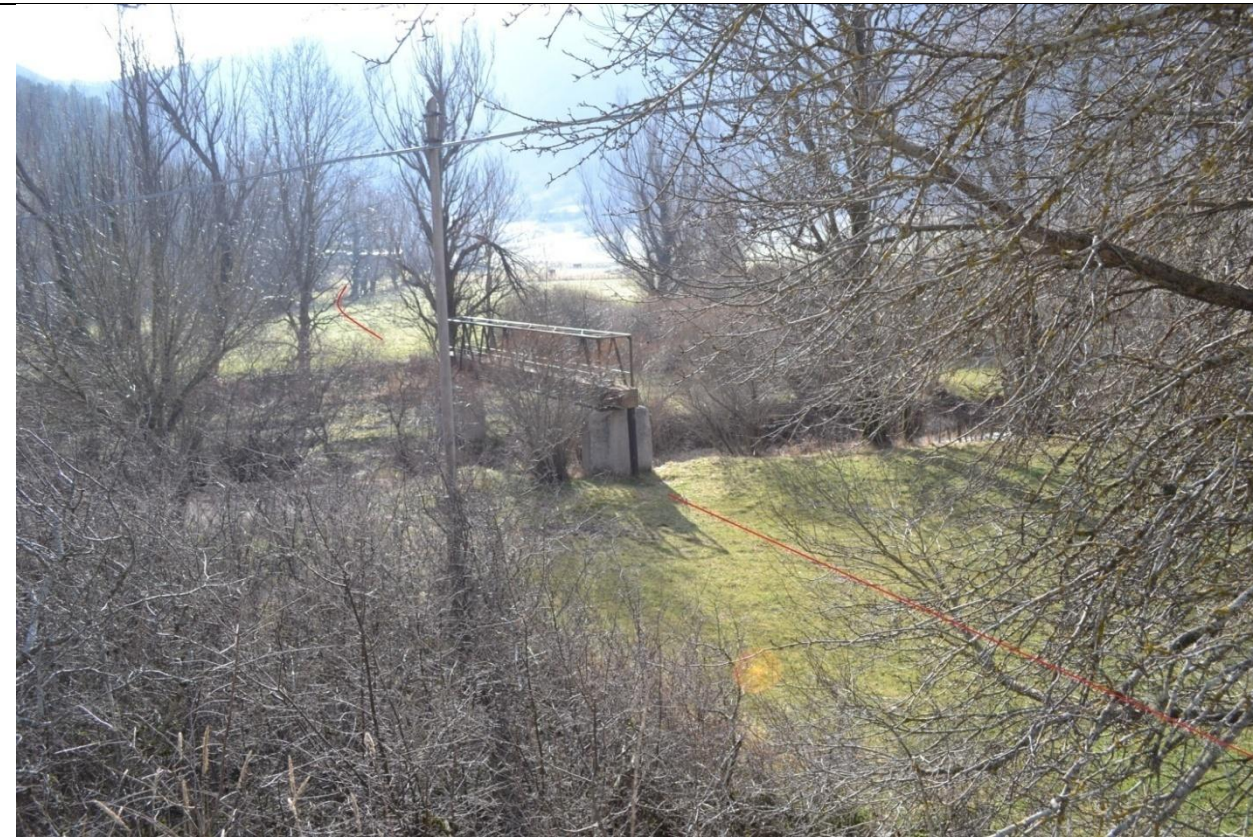
foto 6 tratto di strada di campagna prima di attraversare il fiume Sangro con TOC (sotto alveo)
