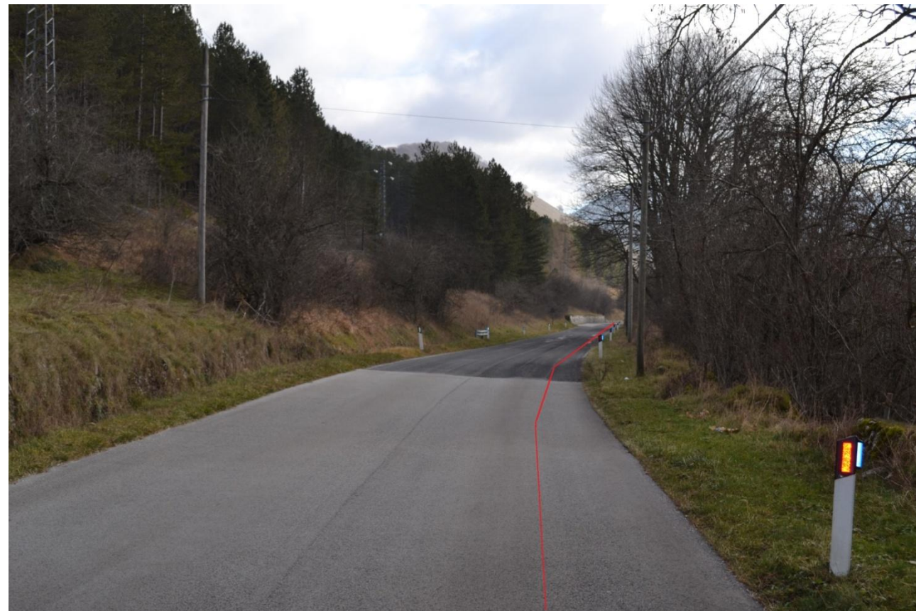
foto 3 tratto di strada provinciale con TOC (sotto strada)
