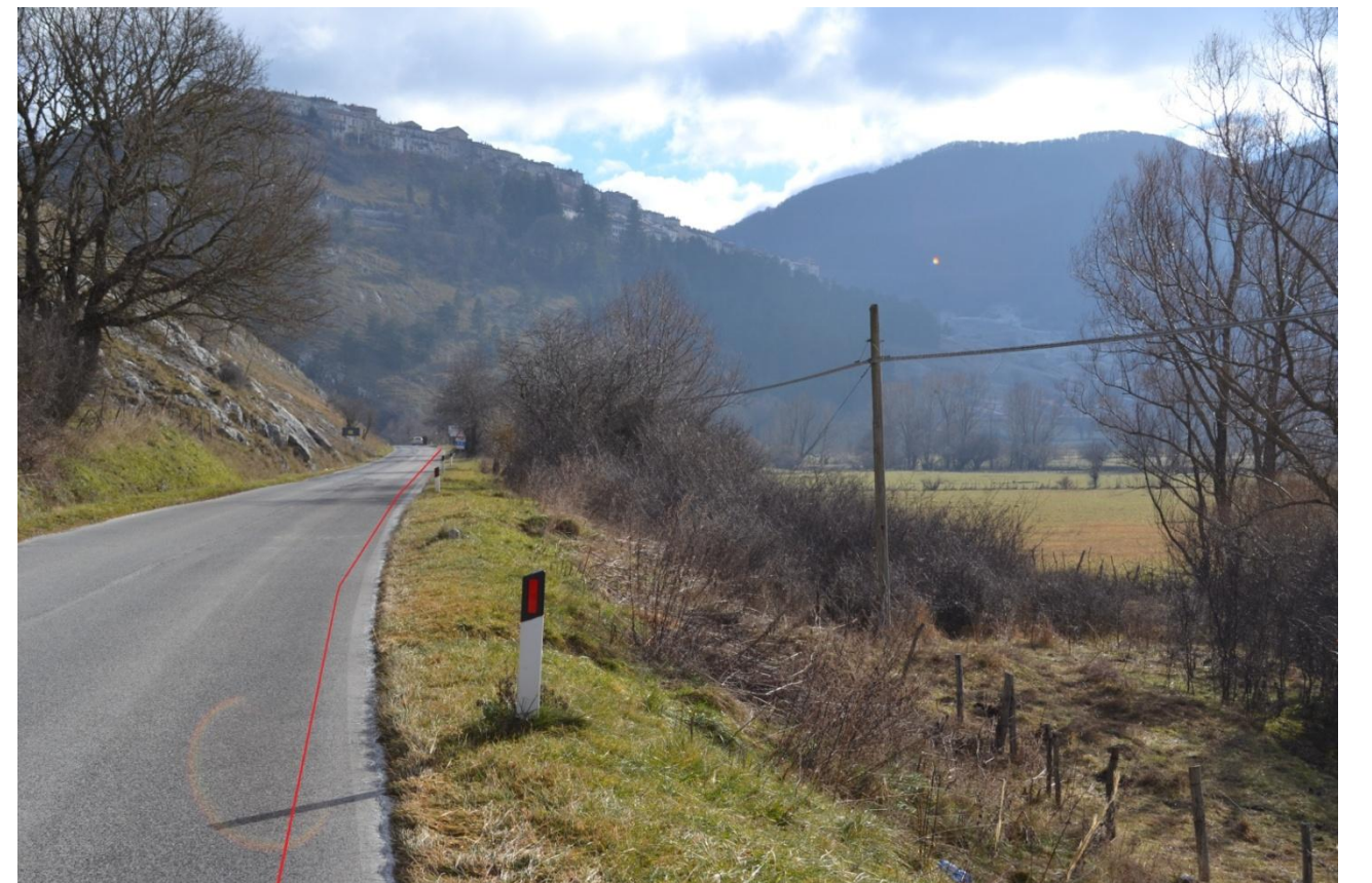
foto 4 tratto di strada provinciale con TOC (sotto strada)
