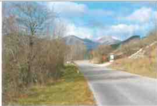
foto 5 vista del punto in cui il collettore passa dal TOC (tutto strada) allo scavo a sezione obbligata in campagna
