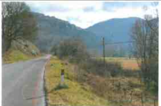
foto 4 tratto di strada provinciale con TOC (foto strada)
