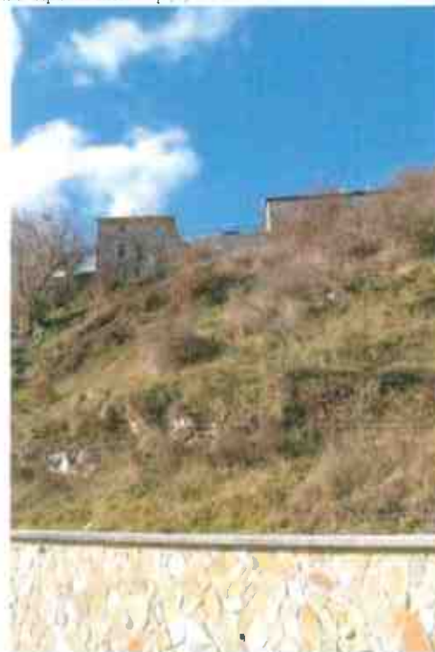
foto 11 (TRATTO 3 TER) scavo in cui la condotta fognaria verrà realizzata lungo il costone di Opi verso la strada comunale
