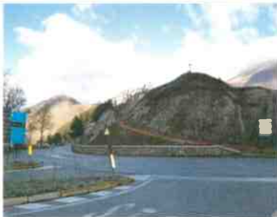
foto 9 (TRATTO 3 E 4) scavo a sezione obbligata dalla strada provinciale Saggio la collina verso Opi (strada pedonale)
