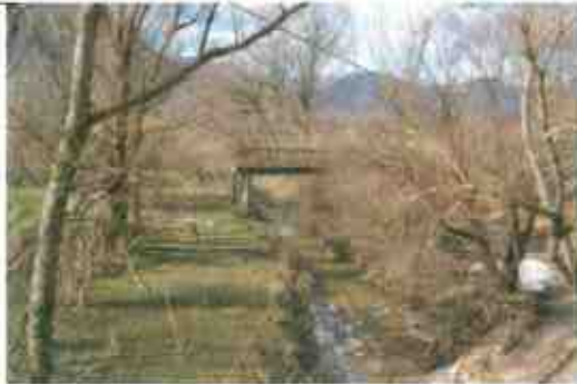
foto 7 scavo di attuamento del fiume Saggio con TOC in chiavica sotto il ponte italiano
