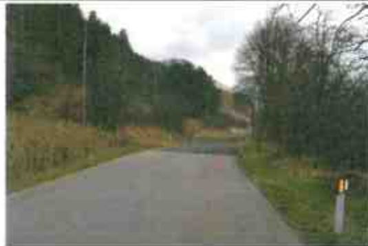
foto 3 tratto di strada provinciale con TOC (foto strada)
