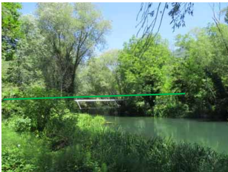
Fig. 21 – (sopra) Tracciato in dismissione proveniente dall'area dei moduli abitativi, raggiunge il fiume Tirino e lo attraversa con tubo sopraelevato.
