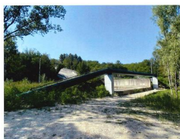
Foto 18 linea aerea esistente (Penne)
