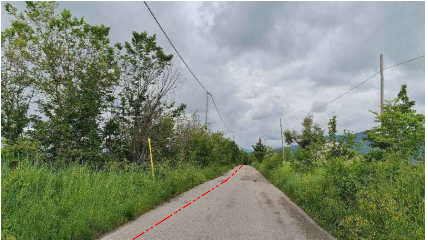
FOTOGRAFIA 75 - Strada Comunale C.da Pluviano (Penne)
