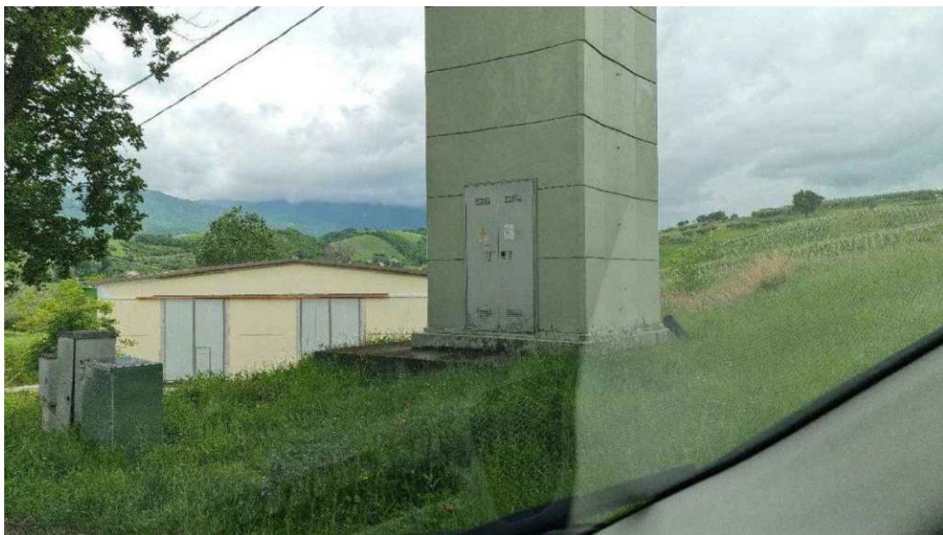
FOTOGRAFIA 67 - Cabina esistente C.da Pluviano (Penne)
