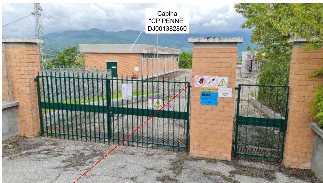
FOTOGRAFIA 80 - Strada Comunale C.da Pluviano (Penne)
