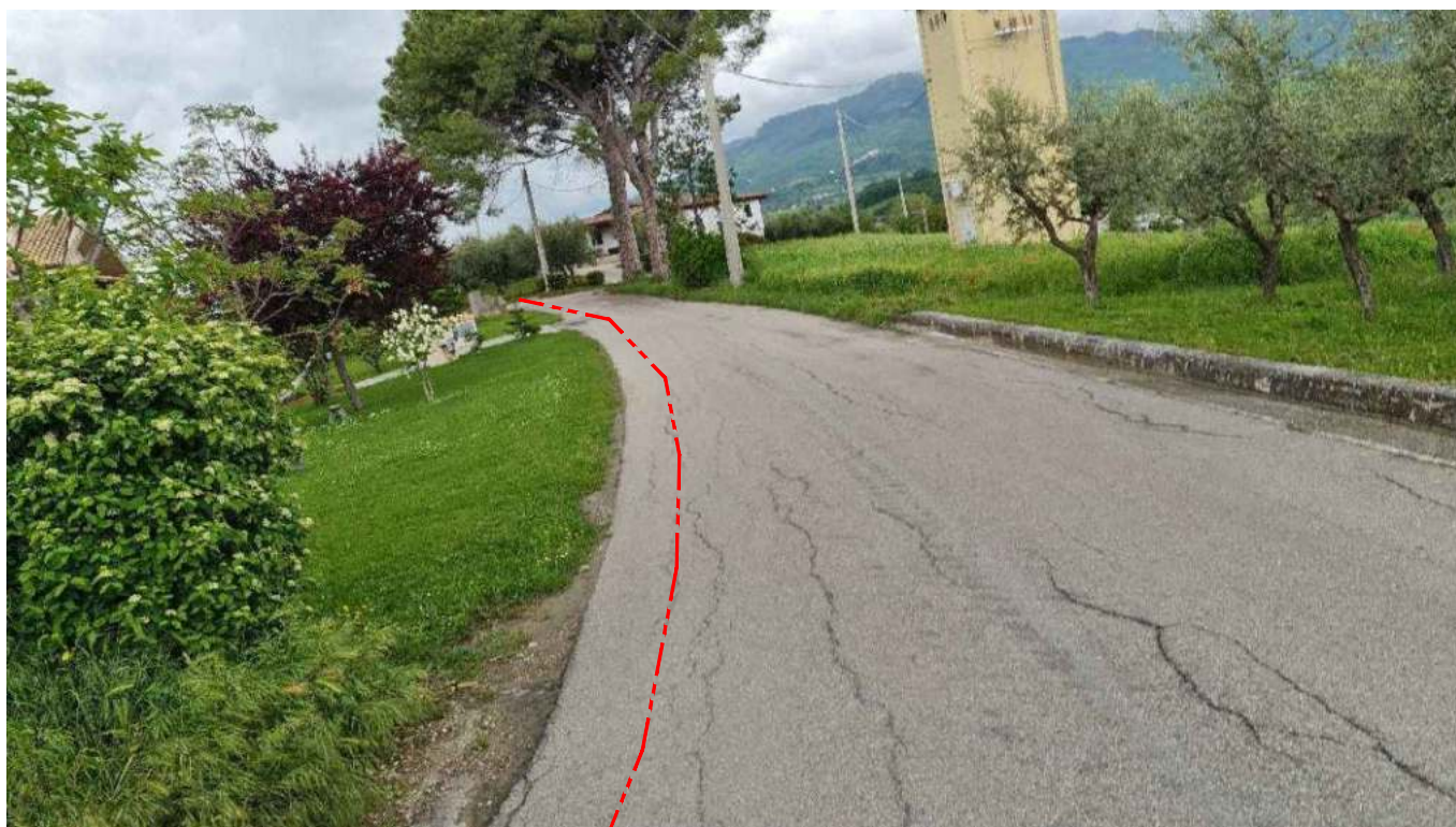
FOTOGRAFIA 73 - Strada Comunale C.da Pluviano (Penne)
