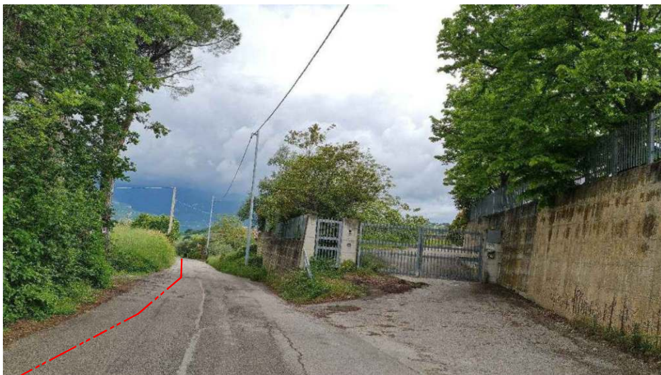
FOTOGRAFIA 77 - Strada Comunale C.da Pluviano (Penne)
