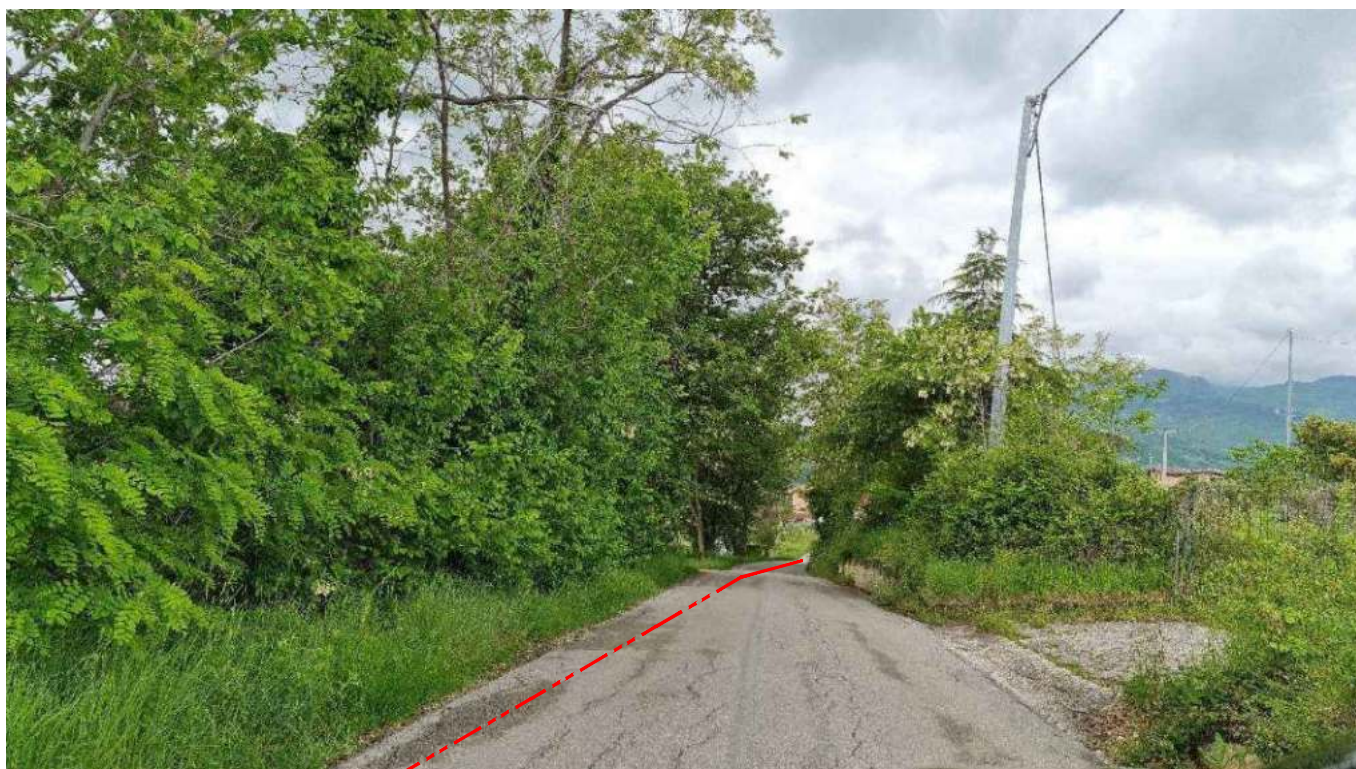
FOTOGRAFIA 74 - Strada Comunale C.da Pluviano (Penne)
