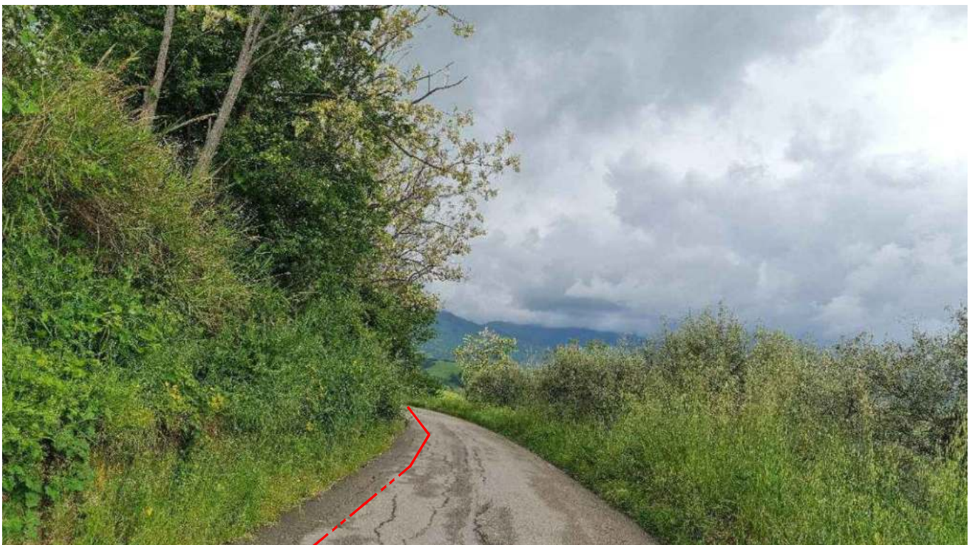
FOTOGRAFIA 76 - Strada Comunale C.da Pluviano (Penne)
