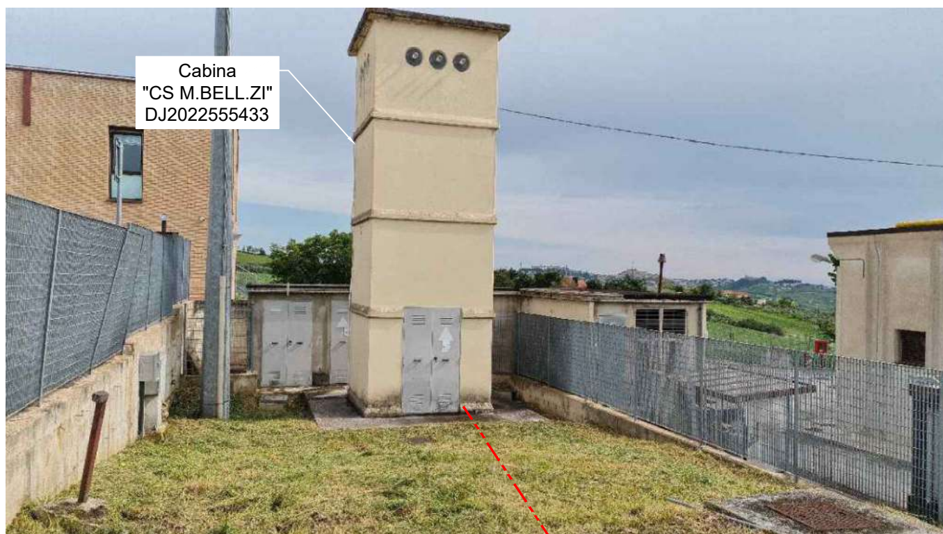
FOTOGRAFIA 1 - Strada Privata (Montebello di Bertona)
