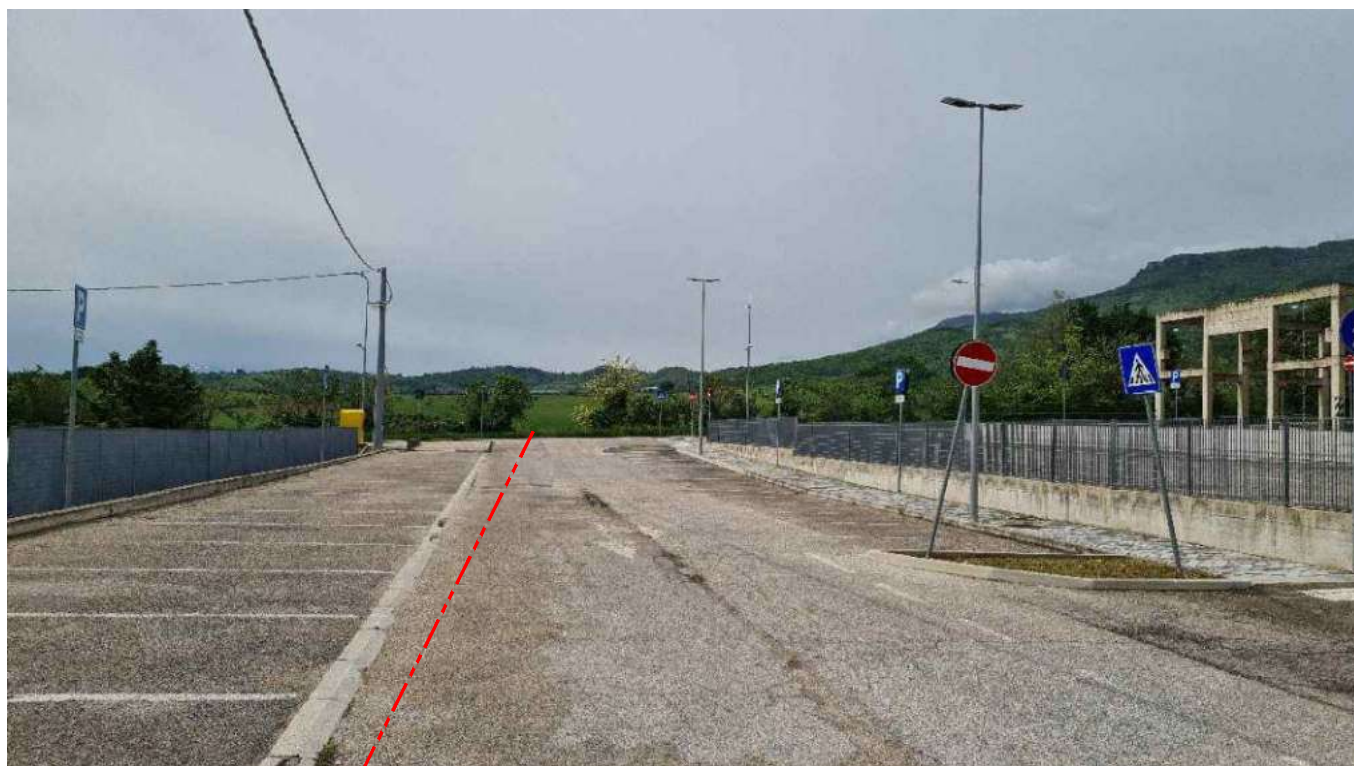
FOTOGRAFIA 2 - Strada privata (Montebello di Bertona)
