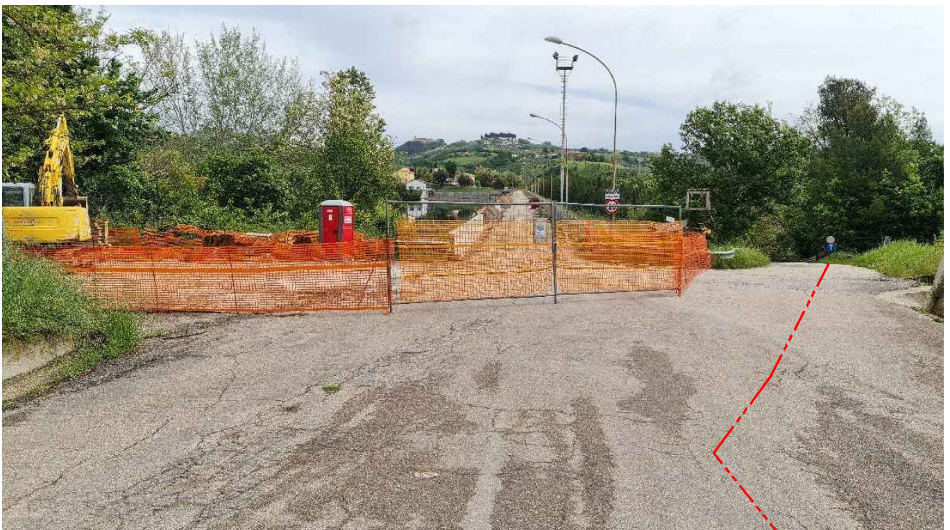
FOTOGRAFIA 44 - Strada comunale (Penne)
