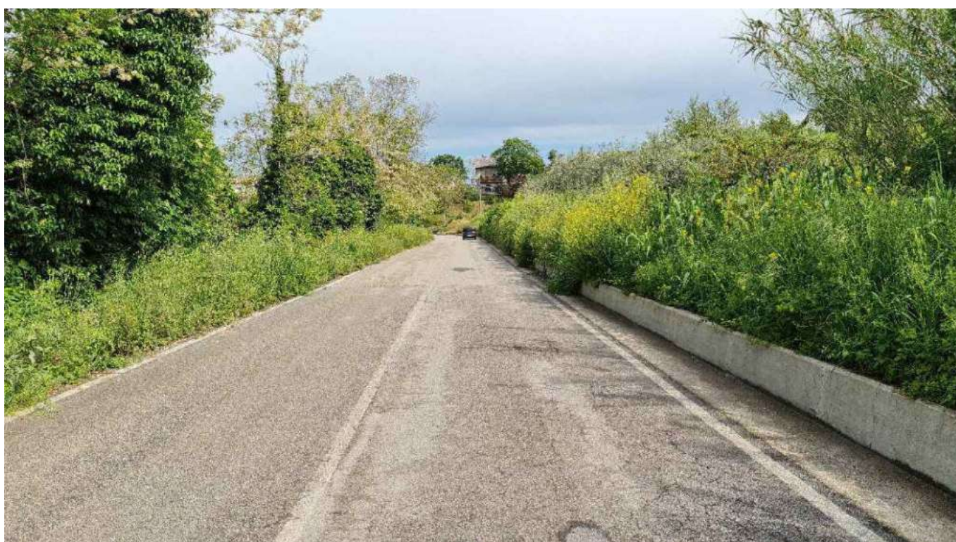
FOTOGRAFIA 18 - S.P.72 (Montebello di Bertona)
