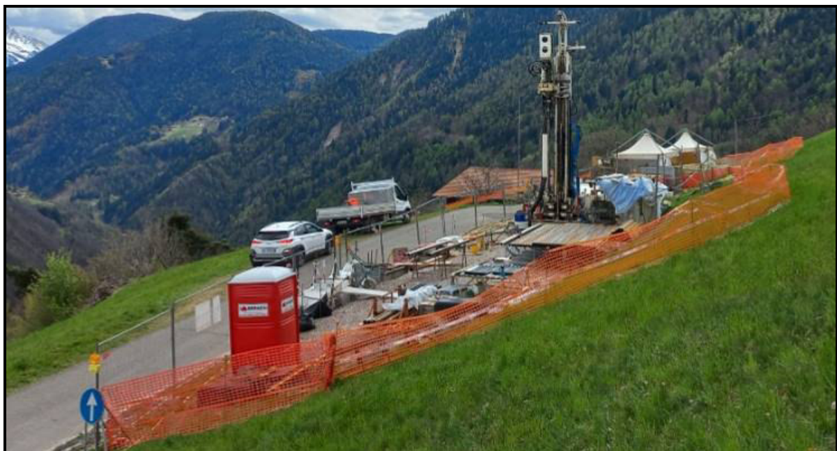
Figure 21 Esempio di sondaggio wire-line
