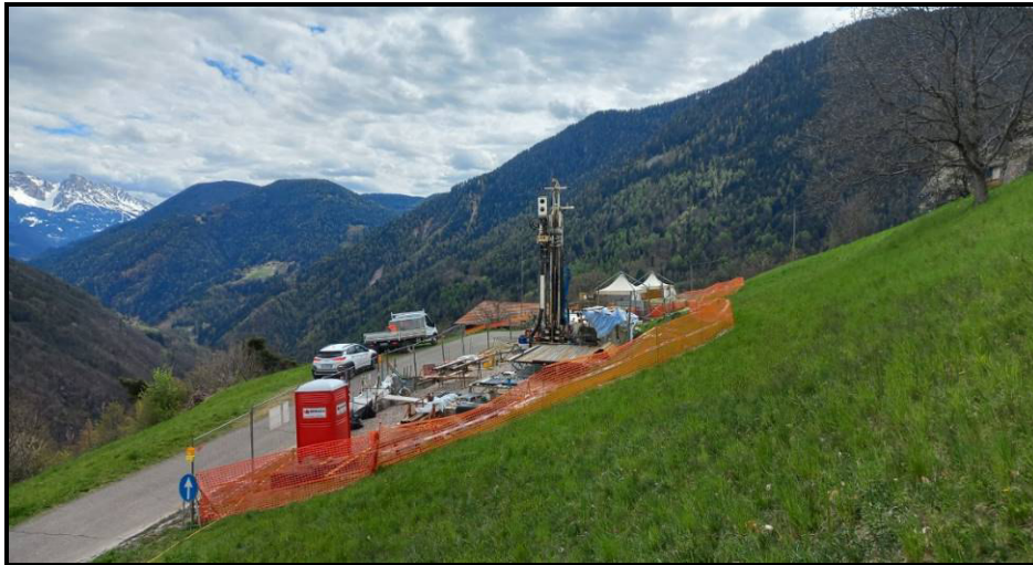
Figure 15 Esempio di sondaggio wire-line
