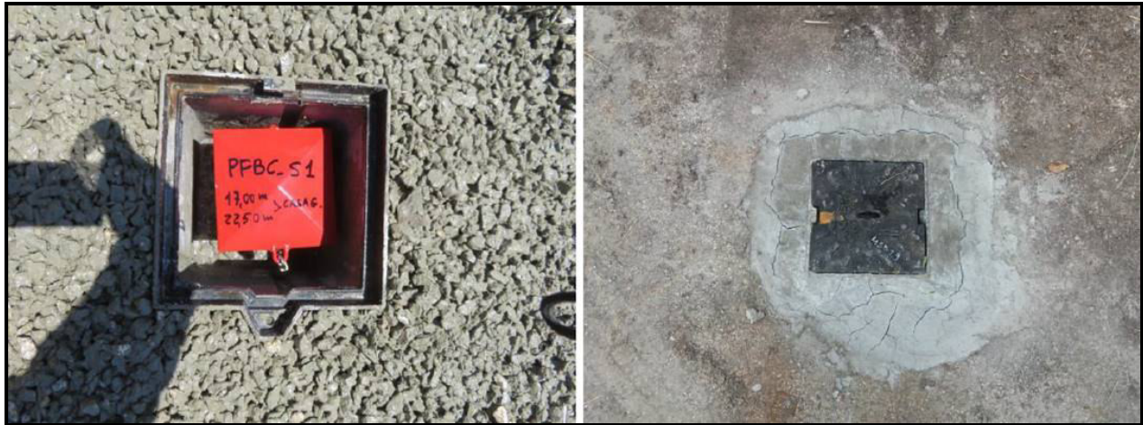
Figure 22. Esempio di pozzetto carrabile
