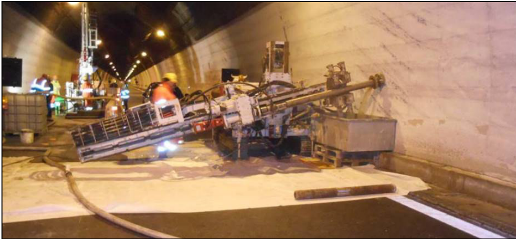
Figure 14 Esempio di sondaggio tradizionale in galleria, con teli protettivi stesi, all'interno dell'area di lavoro, sull'asfalto.
