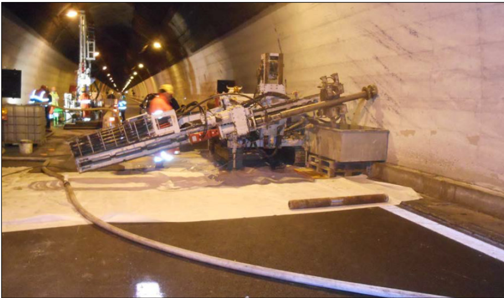
Figura 1. Esempio di sondaggio tradizionale in galleria, con teli protettivi stesi, all'interno dell'area di lavoro, sull'asfalto.
