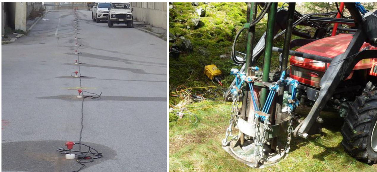
Figura 12. Modalità installazione geofoni (foto di sinistra) e dispositivo di energizzazione montato su trattore (foto di destra)
