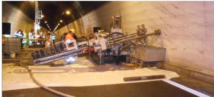
Figure 14 Esempio di sondaggio tradizionale in galleria, con teli protettivi stesi, all'interno dell'area di lavoro, sull'asfalto.
