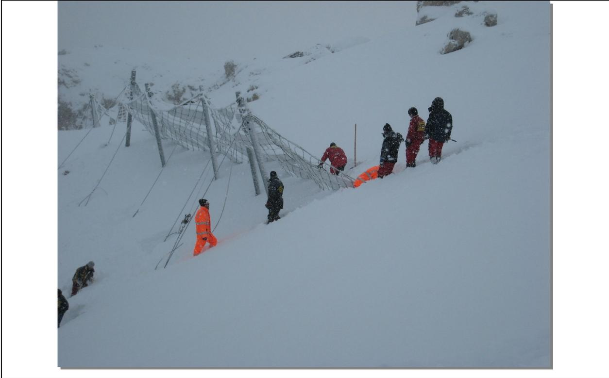
*Figura 21 Fasi finali del montaggio di reti fermaneve*
