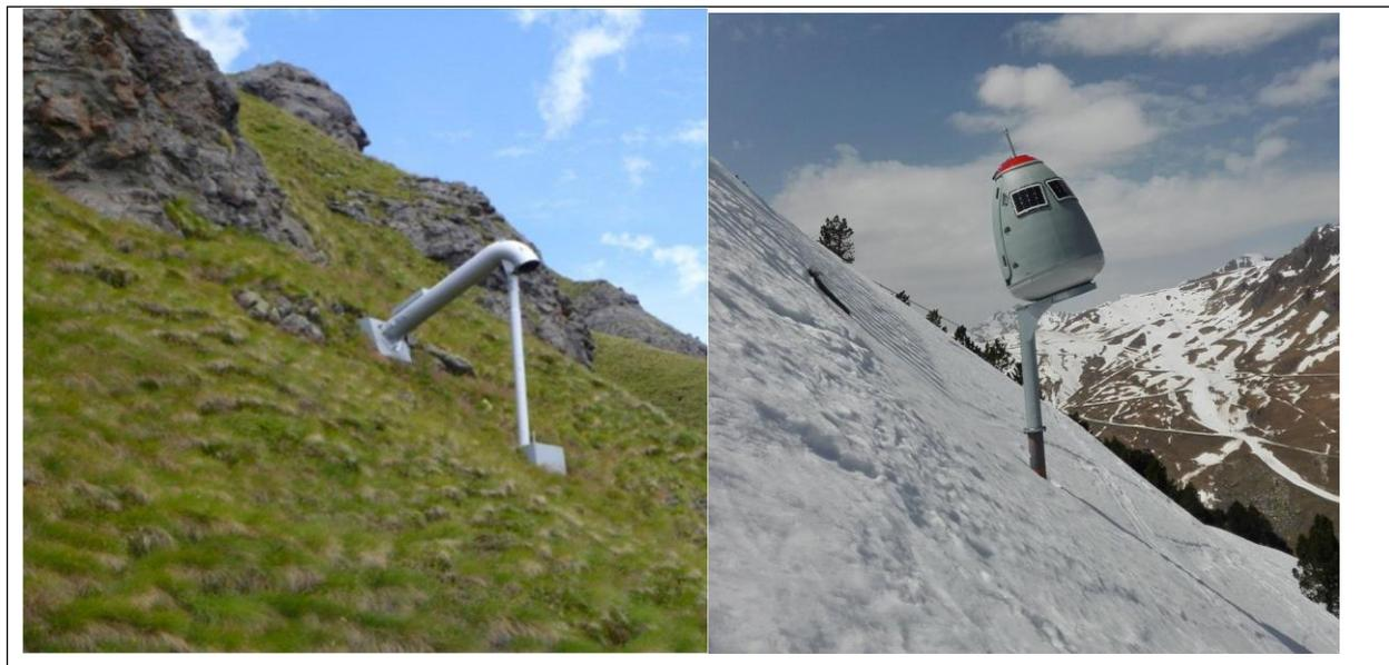
*Figura 20 Esempio di Gazex (a sinistra) e O'bellx (a destra)*
