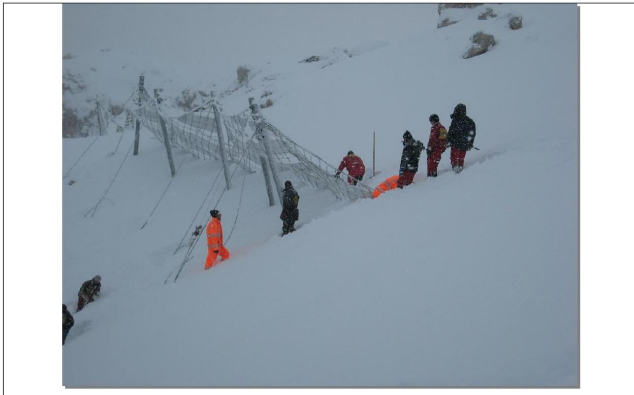
*Figura 21 Fasi finali del montaggio di reti fermaneve*
