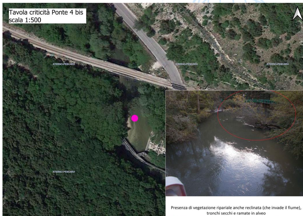
Figura 32 - Presenza di vegetazione ripariale anche reclinata (che invade il fiume), tronchi secchi e ramate in alveo in prossimità del ponte 4 bis.
