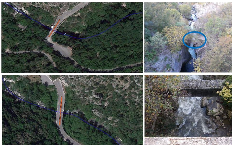
Figura 16- a) localizzazione infrastruttura "A" a valle del ponte 1. B) localizzazione infrastruttura "B" a valle del ponte 3
