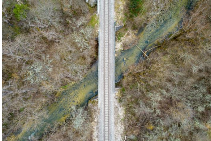
Figura 31 – Ponte 10, Tione Degli Abruzzi
