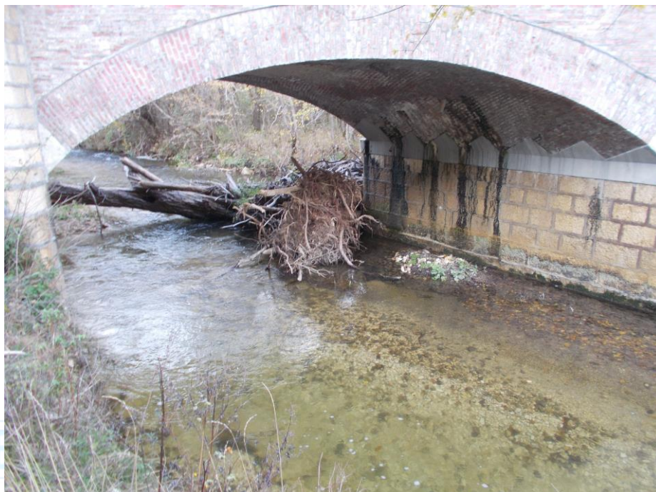
Figura 43 - Presenza di tronchi secchi e ramate in alveo anche di grandi dimensioni. Situazione particolarmente delicata per probabile utilizzo della struttura come rifugio diurno della lontra.
