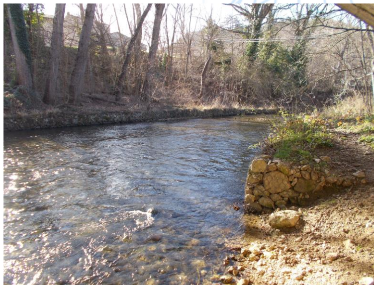
Figura 42 – Gabbionati esistenti sul ponte 7 - bis
