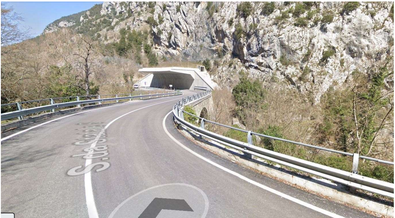
vista lato monte
