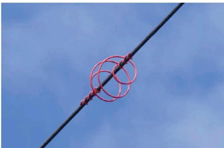
Fig.8 Spirale colorata in plastica per la segnalazione dei cavi.
