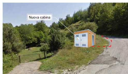
FOTOGRAFIA 10 - Strada Provinciale n. 44
