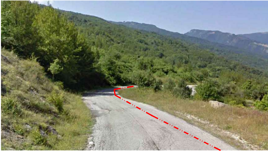
FOTOGRAFIA 9 - Strada Provinciale n. 44
