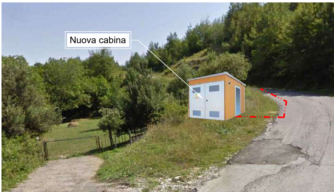
FOTOGRAFIA 10 - Strada Provinciale n. 44
