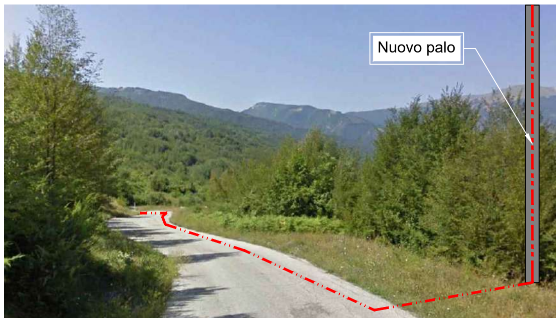
FOTOGRAFIA 8 - Strada Provinciale n. 44
