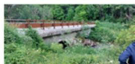
Foto 1-3 Comune di Acciano - Ponte Romano - stato dei luoghi nel Giugno 2023
