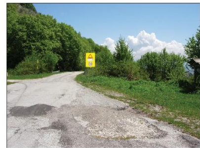
Foto 6 Posa in opera di segnaletica direzionale per sci di fondo escursionistico, posa in opera di pannello per sci di fondo escursionistico, posa in opera di palo di sostegno e relativo ancoraggio e bacheca punti tappa sentieristica
