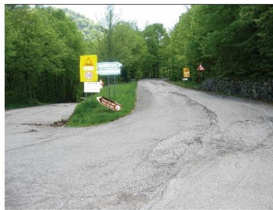
Foto 5 Posa in opera di segnaletica direzionale per sci di fondo escursionistico, posa in opera di pannello per sci di fondo escursionistico e posa in opera di palo di sostegno e relativo ancoraggio
