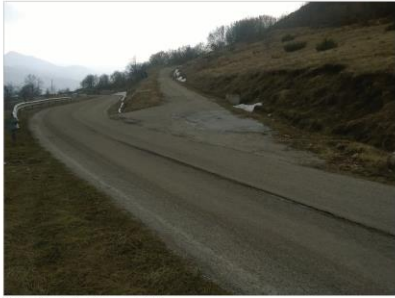
Foto 1 Punto A - Partenza / Arrivo Pannello sentieristica, palo per segnaletica e tabelle segnavia
