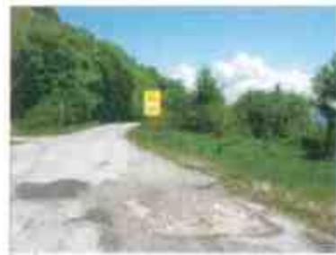
Foto 6 Pista in opera di segnalazione di percorso per uso di fondo escursionistico, e parte in opera di palo di sostegno di pedana o sentinella.
