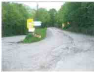
Foto 5 Pista in opera di segnalazione di percorso per uso di fondo escursionistico, e parte in opera di palo di sostegno di pedana o sentinella.
