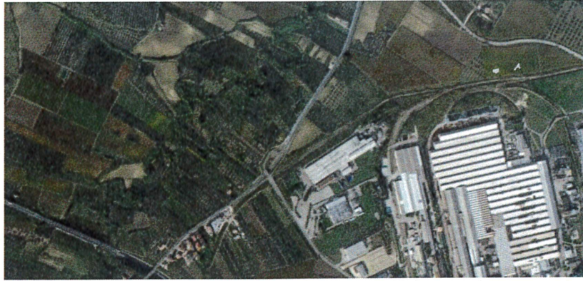
Foto2_Inquadramento vista dall'alto
