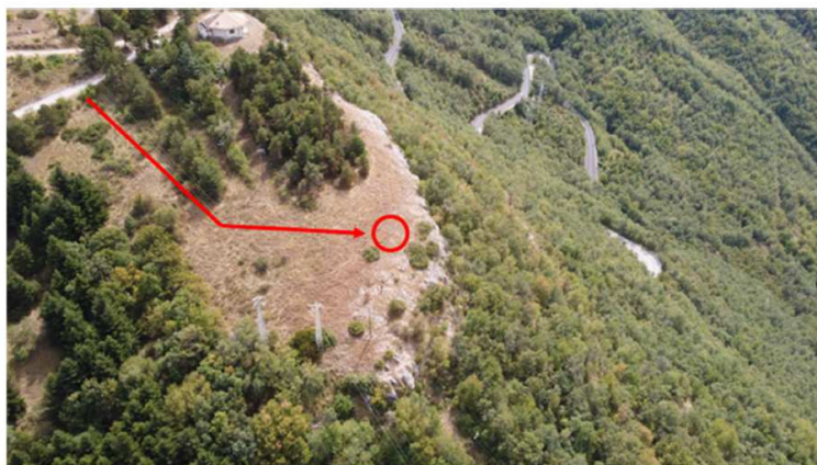
Foto 1 – Localizzazione stazione di partenza, strada di accesso e area di cantiere
