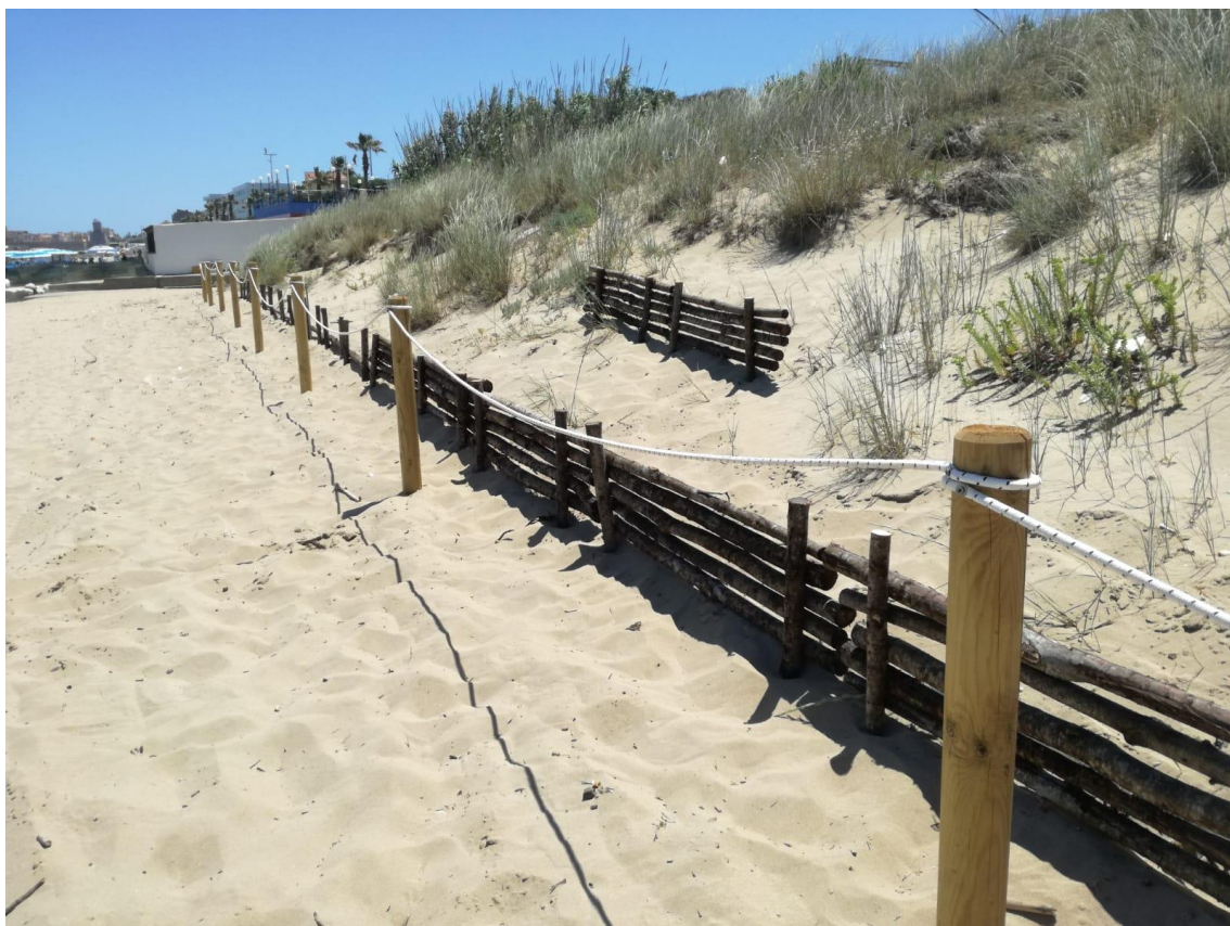
Esempio di bioricostruzione con viminate e successiva piantumazione
