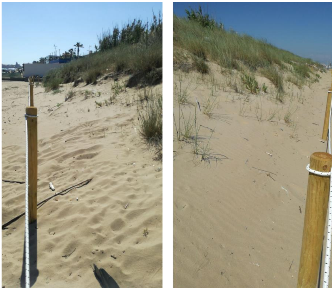
Esempio di Pali e corde guida a protezione della duna (Foto Progetto di riqualificazione Termoli – Lungomare Nord).
