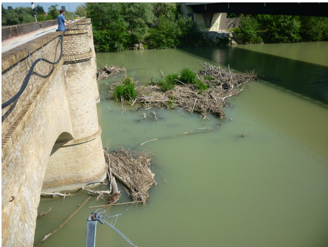
Foto 58 – vista dal ponte ex tracciato ferroviario degli isolotti D e E
