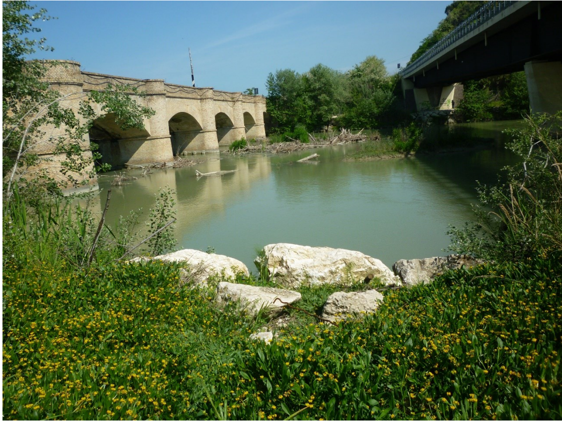
Foto 37 – vista del punto da cui si accederà in alveo con l'escavatore
