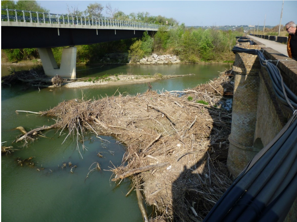
Aprile 2017 – Ponte SS 16 ed ex tracciato ferroviario
