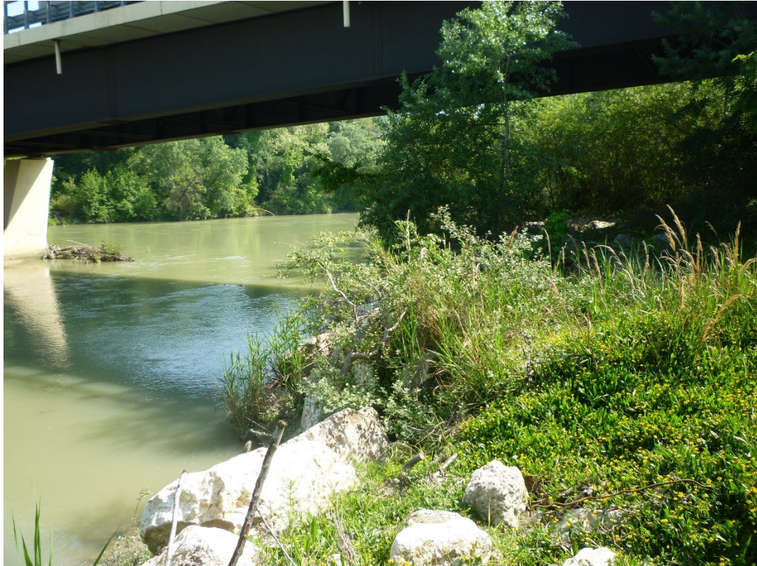
Foto 39 – vista dal punto di accesso per la rimozione degli isolotti D – E, verso il ponte della S.S. 16
