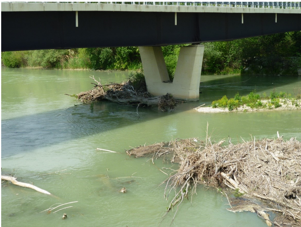
Maggio 2017 – Ponte SS 16
