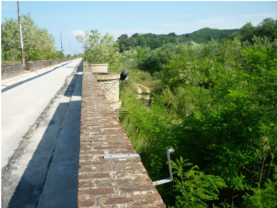
Foto 47 – vista dal ponte ex tracciato ferroviario della strada esistente
