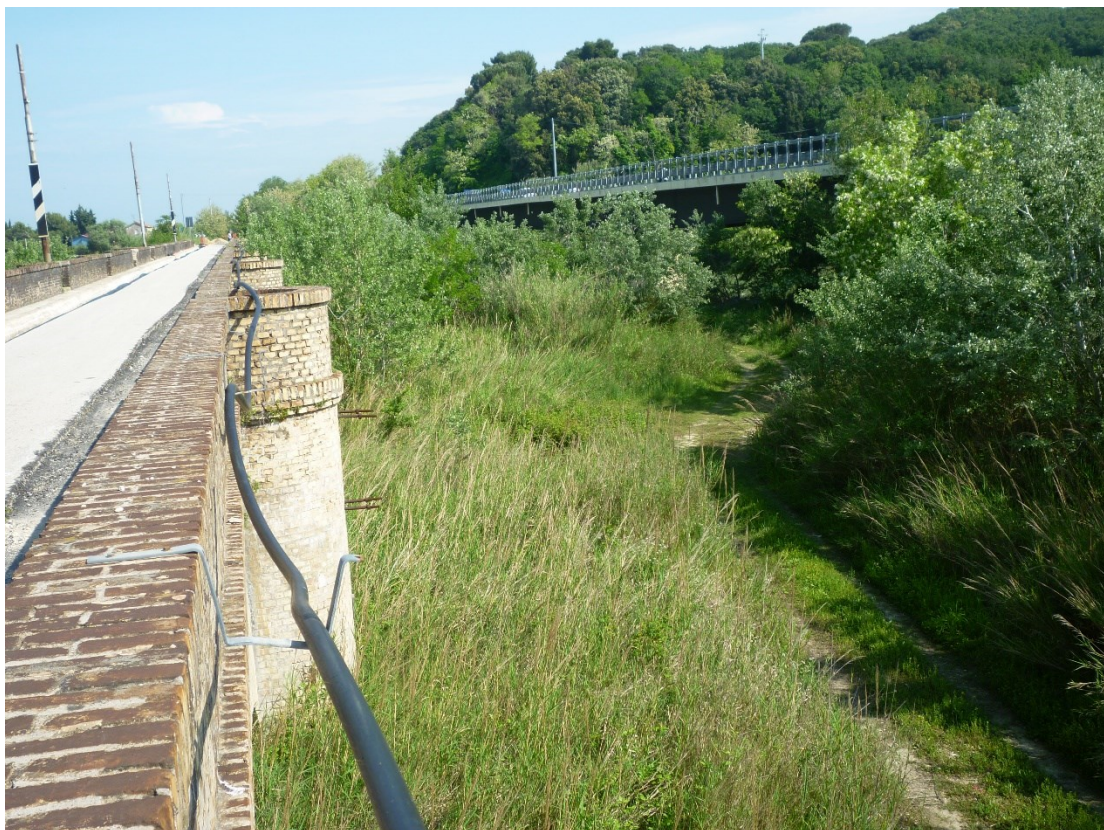
Foto 49 – area dove realizzare il passaggio per accedere sull'altro lato del ponte
