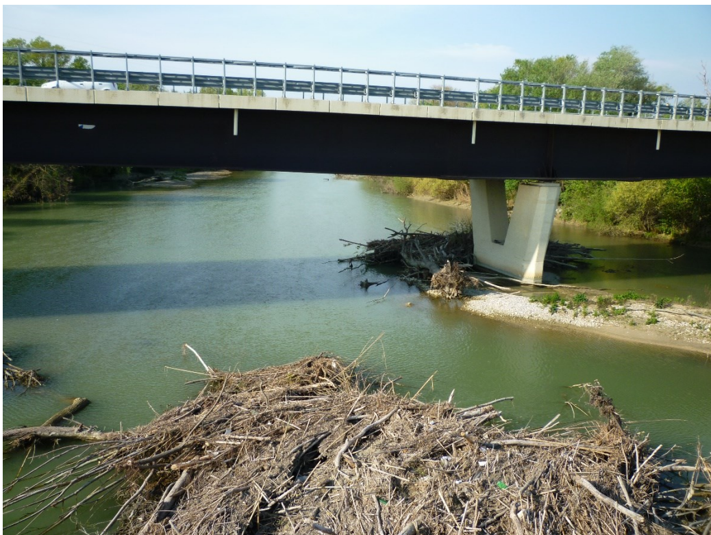
Aprile 2017 – Ponte SS 16
