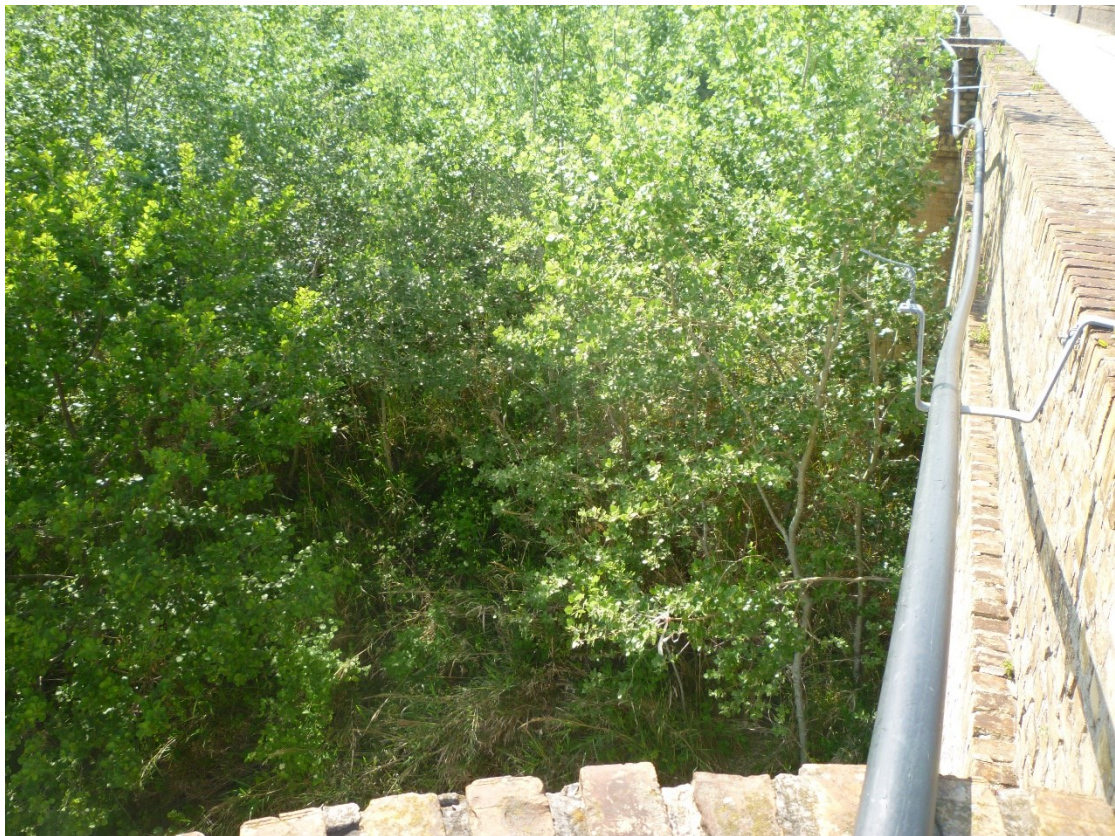
Foto 52 – vista dal ponte della vegetazione da tagliare
