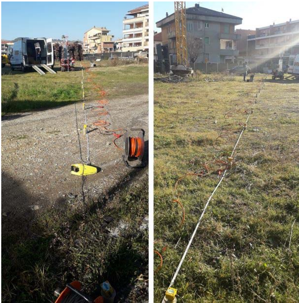
Fig. 3 - Prospezione sismica MASW effettuata sul sito oggetto di studio: è visibile lo stendimento in preparazione per il posizionamento dei geofoni.
