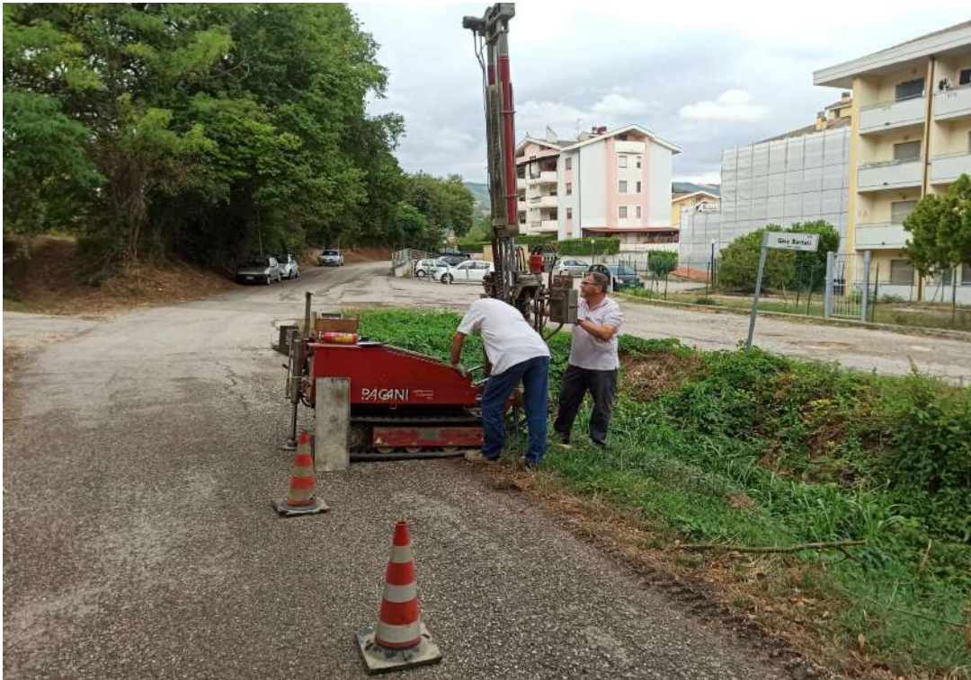
Ubicazione prova penetrometrica DPSH (P1)
