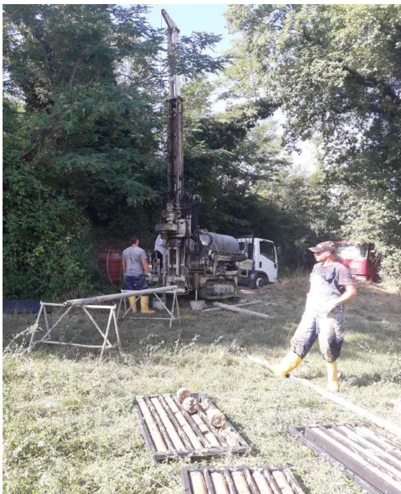
Ubicazione sondaggio S1
