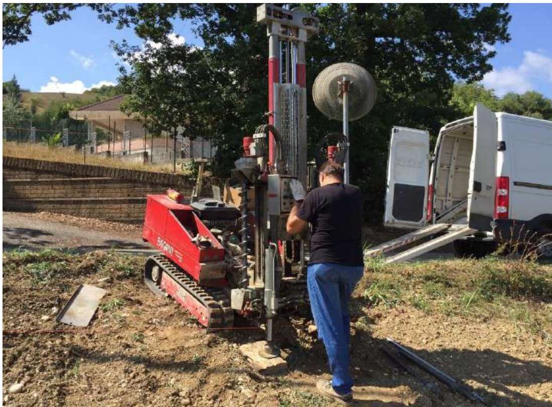
Ubicazione prova penetrometrica DPSH (P3)
