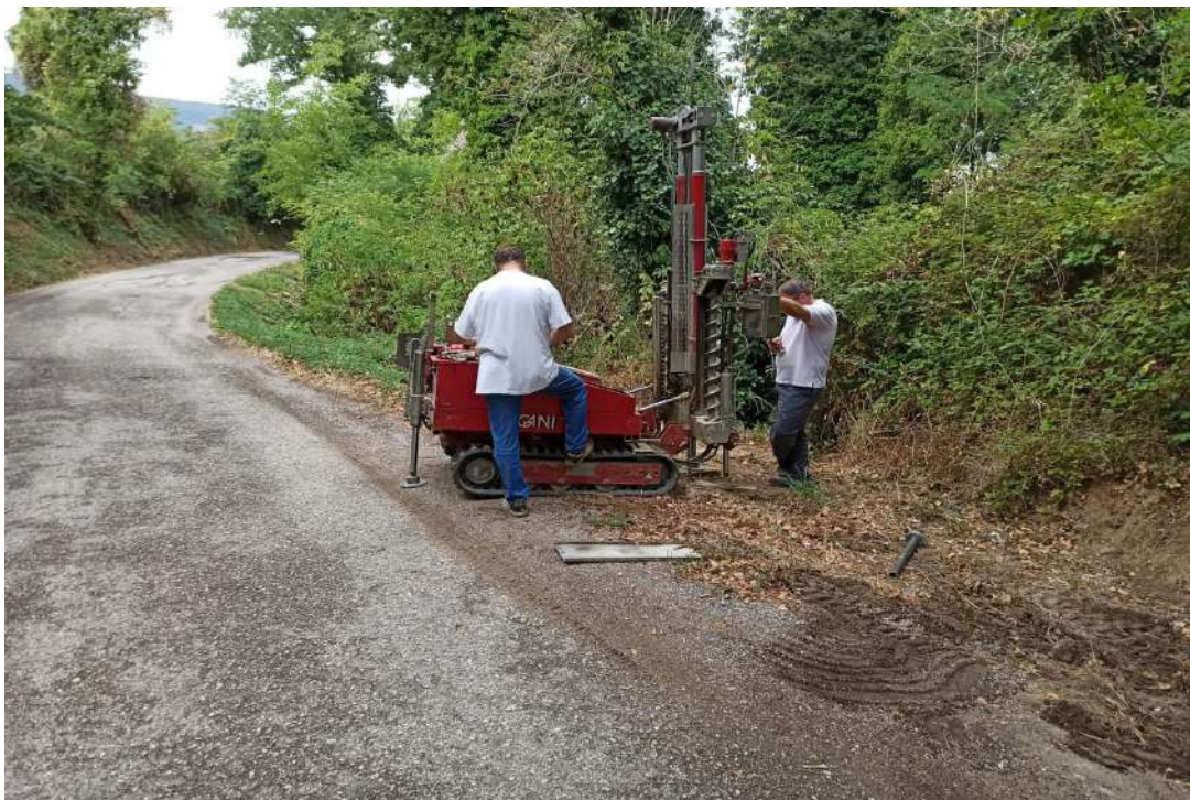
Ubicazione prova penetrometrica DPSH (P2)
