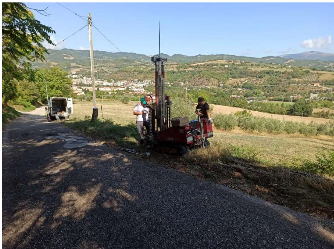
Ubicazione prova penetrometrica DPSH (P7)
