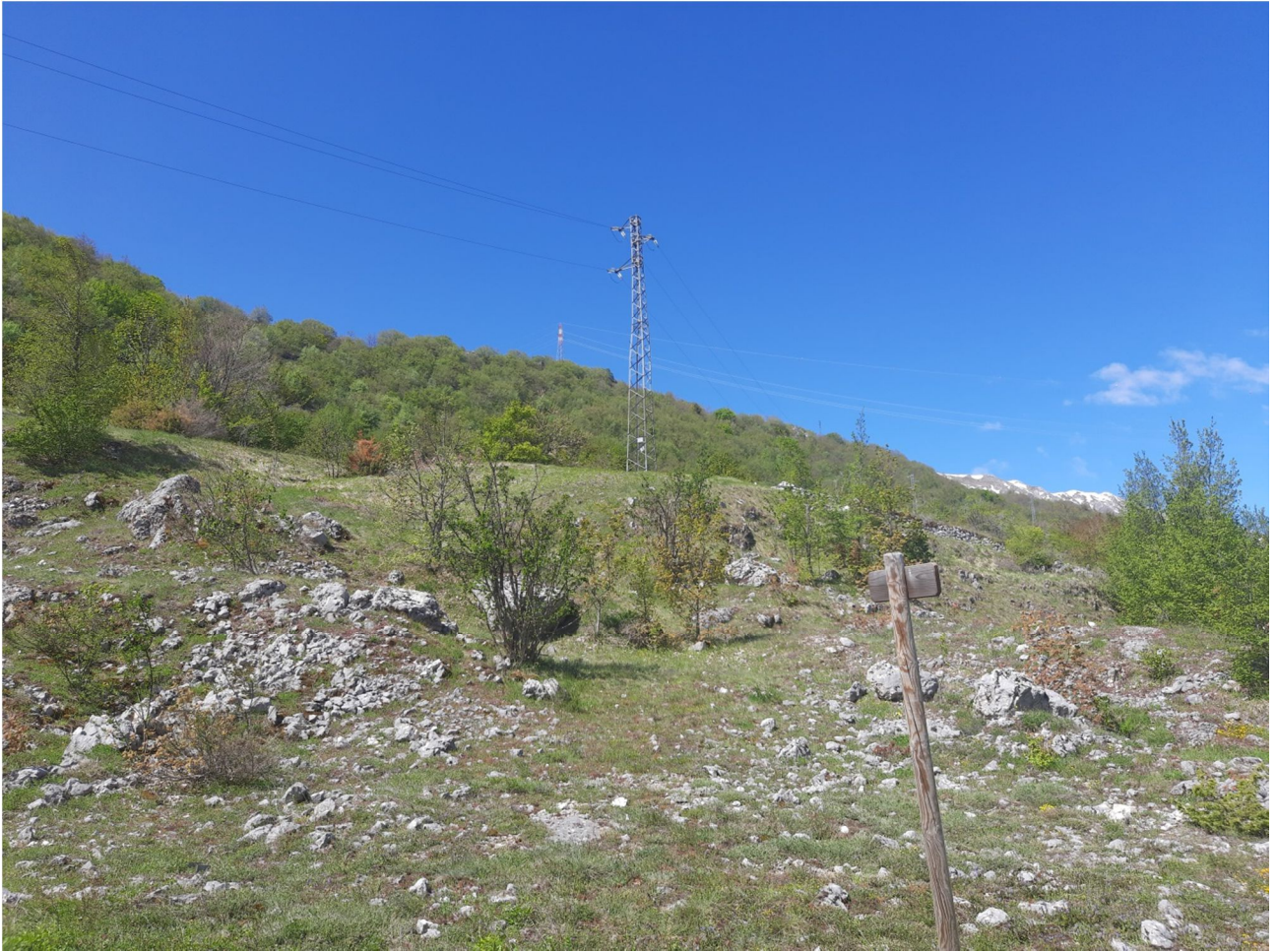
Linea proveniente da Cerri che incrocia la SP38
