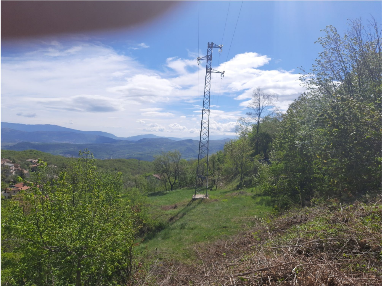
Linea proveniente da Cerri dopo aver attraversato la SP 38
