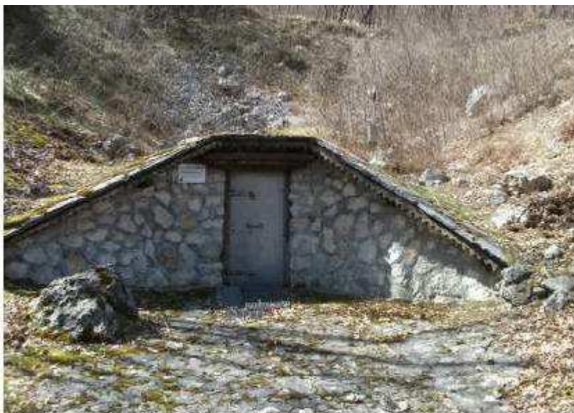
Figura 4 – Ripresa fotografica della struttura muraria esterna del bottino di presa della concessione mineraria “Sant’Antonio Sponga”.
