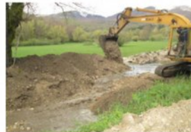
Ripristino Argine Fiume Sangro
