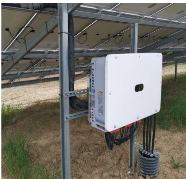
Inverter montato in campo.
