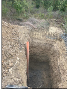
Realizzazione delle trincee ed installazione dei tubi piezometrici eseguiti a cura della committenza.
