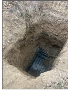
Realizzazione delle trincee ed installazione dei tubi piezometrici eseguiti a cura della committenza.
