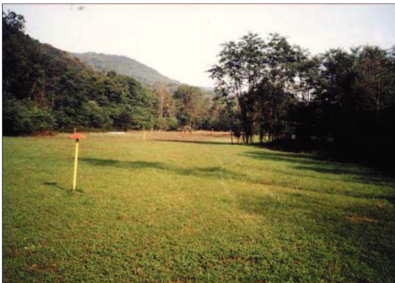
Figura 6.a: Esempio di Pista Lavori a Ripristini Ultimati su un Gasdotto in Esercizio
