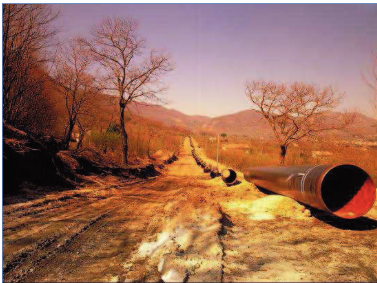
Figura 3.c: Foto delle Tipiche Operazioni di Sfilamento tubazioni
