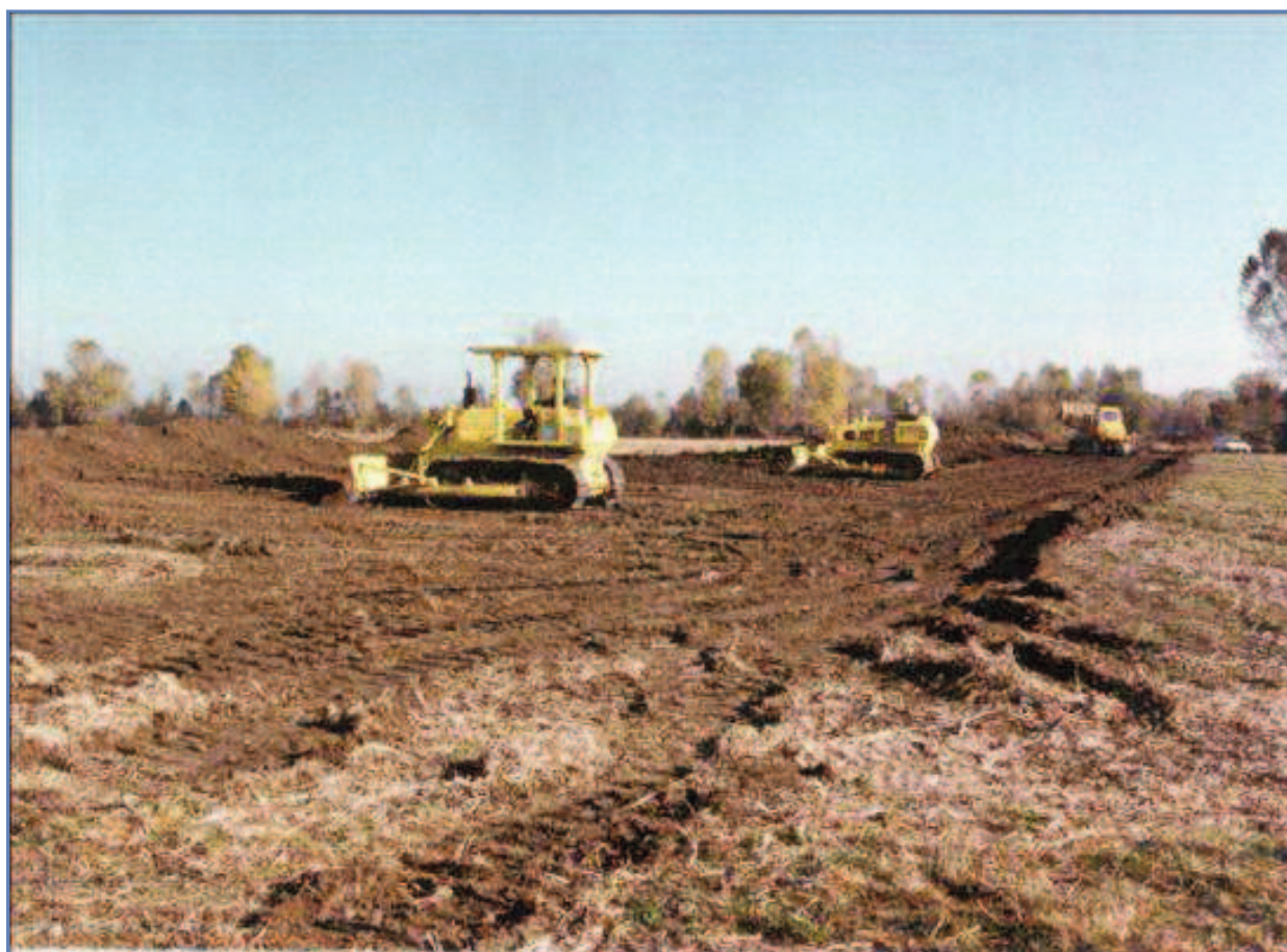
Figura 3.b: Foto delle Tipiche Operazioni di Apertura dell'Area di Passaggio
