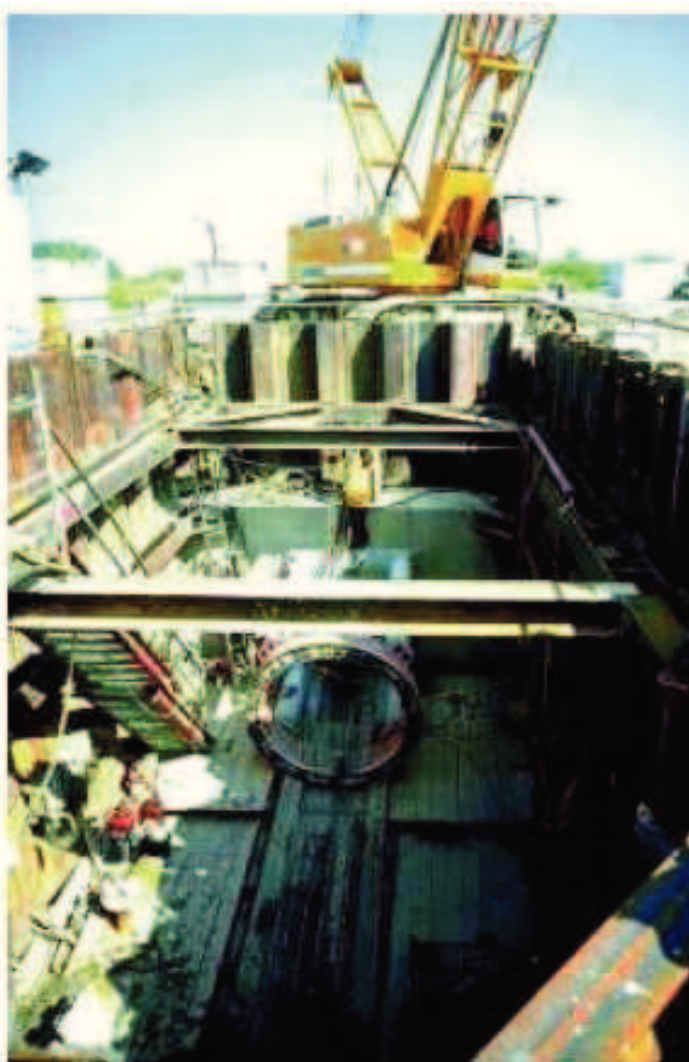
Figura 3.f: Esempio di Postazione di Spinta per Microtunnel
