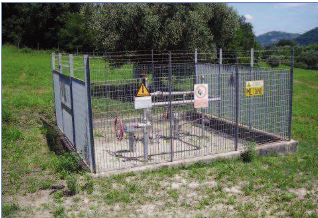
Figura 3.g: Esempio di Punti di Intercettazione di Linea (PIL)
