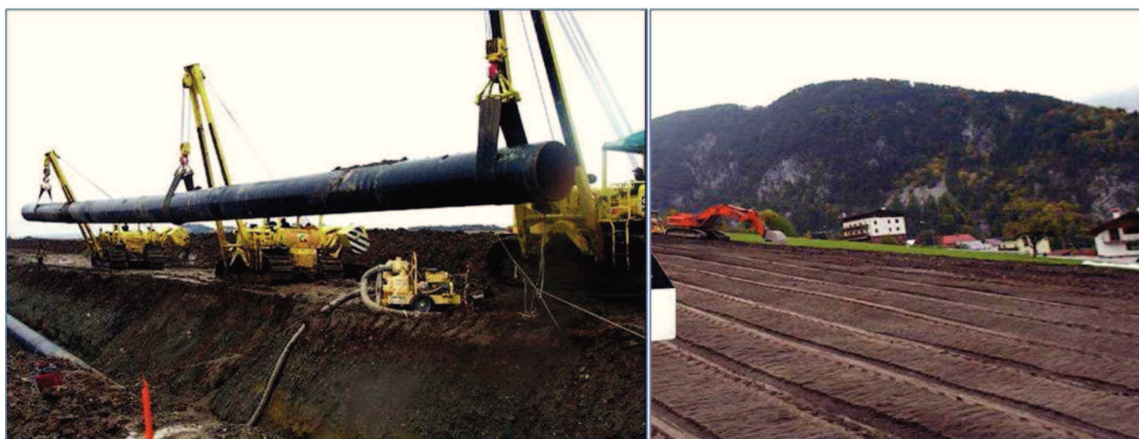
Figura 3.e: Foto delle Tipiche Operazioni di Posa della Condotta
