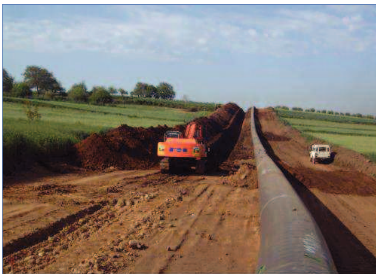
Figura 3.d: Foto delle Tipiche Operazioni di Scavo della Trincea
